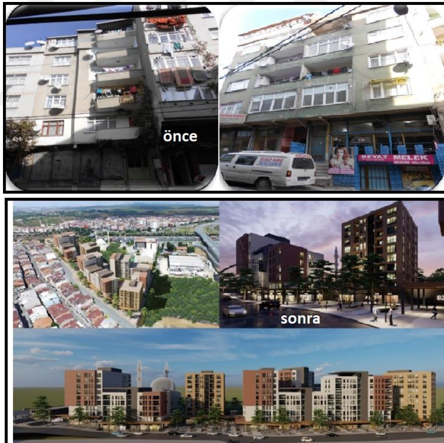
Şekil 6.12. Esenler ilçesi oruçreis mahallesi gecekondur önleme bölgesi riskli alan kentsel dönüşüm projesi öncesi ve sonrası durumu
