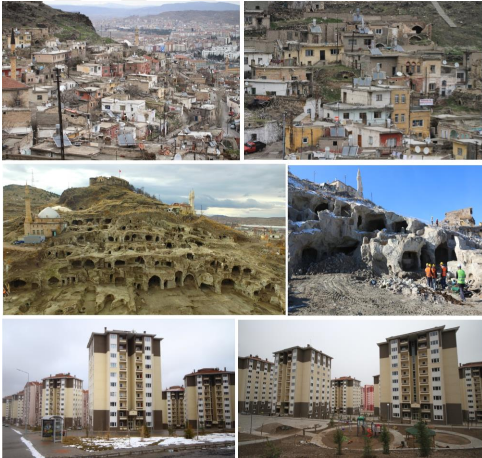
Şekil 6.10. Nevşehir ili Merkez kale etrafı-Mehmet Akif Ersoy mahallesi kentsel dönüşüm projesine ilişkin görüntüler
