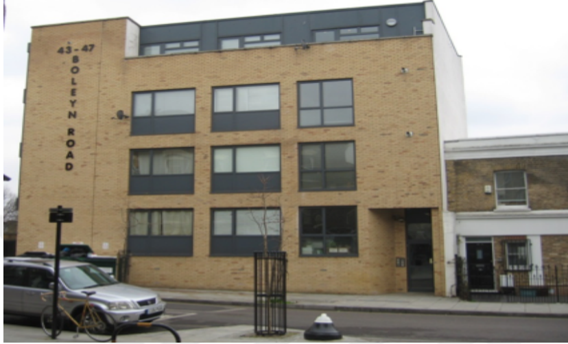
Şekil 3.63. Boleyn Road Binası'nın ön görünüşü (Anonim 24)
