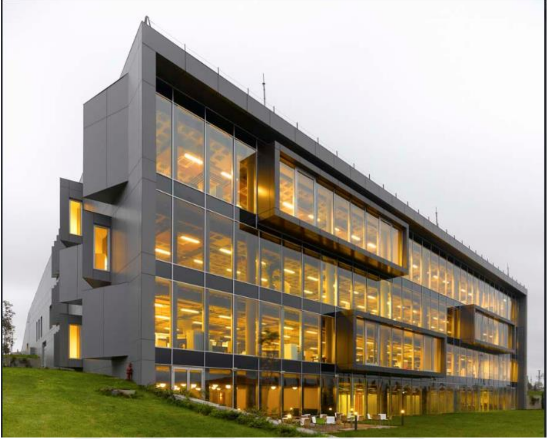
Şekil 2.11. Turkcell Ar&Ge Binası (Türkiye, Kocaeli) (URL-6)
