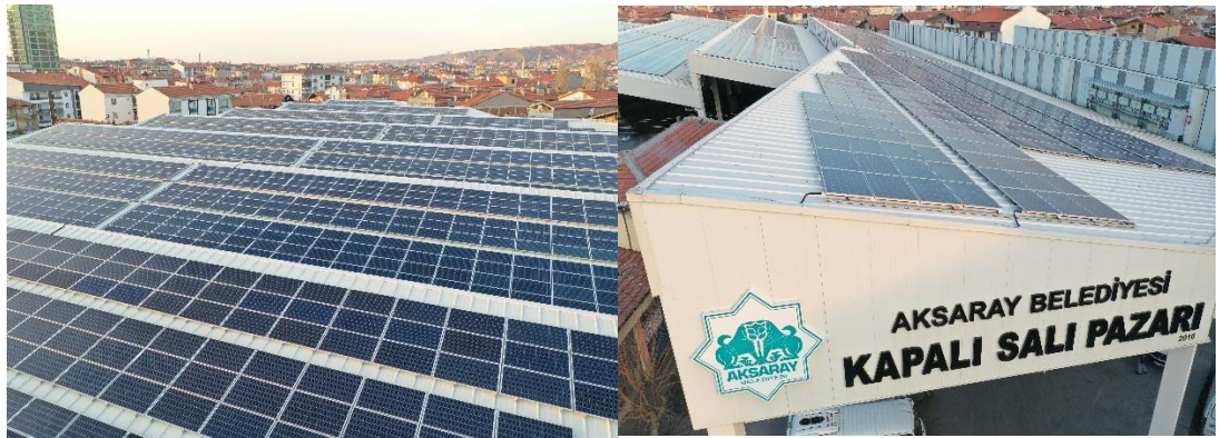
Şekil 4.12. Aksaray güneş paneli uygulaması-2 (URL-13).
