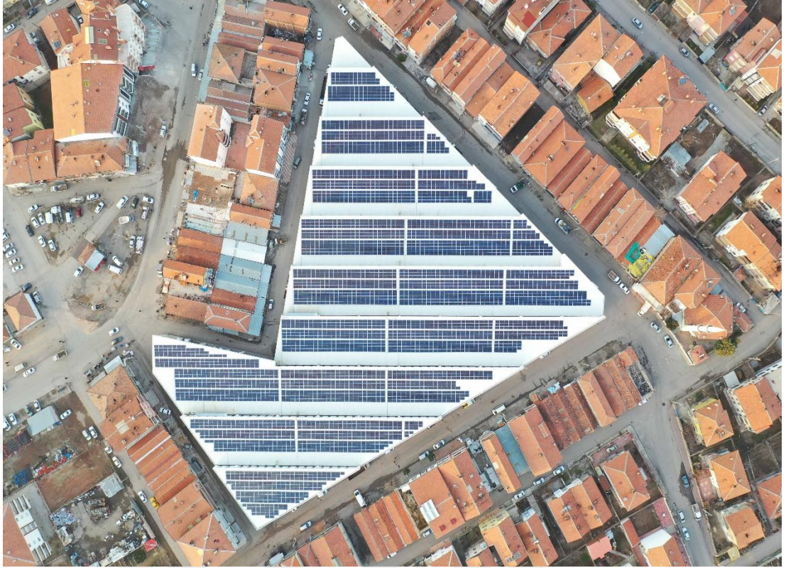
Şekil 4.11. Aksaray güneş paneli uygulaması-1 (URL-13).
