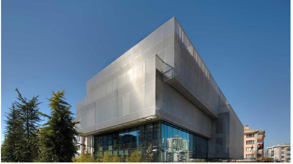
Şekil 4.5 Türkiye Mühendisler Birliği Merkez Binası Güney Cephesi – Mesh sistemin dış görünüşü (Avcı Architects 2014).
