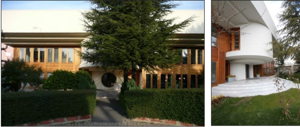
Şekil 4.17. Şevki Vanlı Mimarlık Bürosu (Demirel Etlı, 2013)
