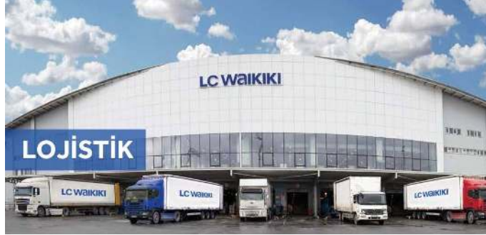
Şekil 80. LC Waikiki lojistik binası
