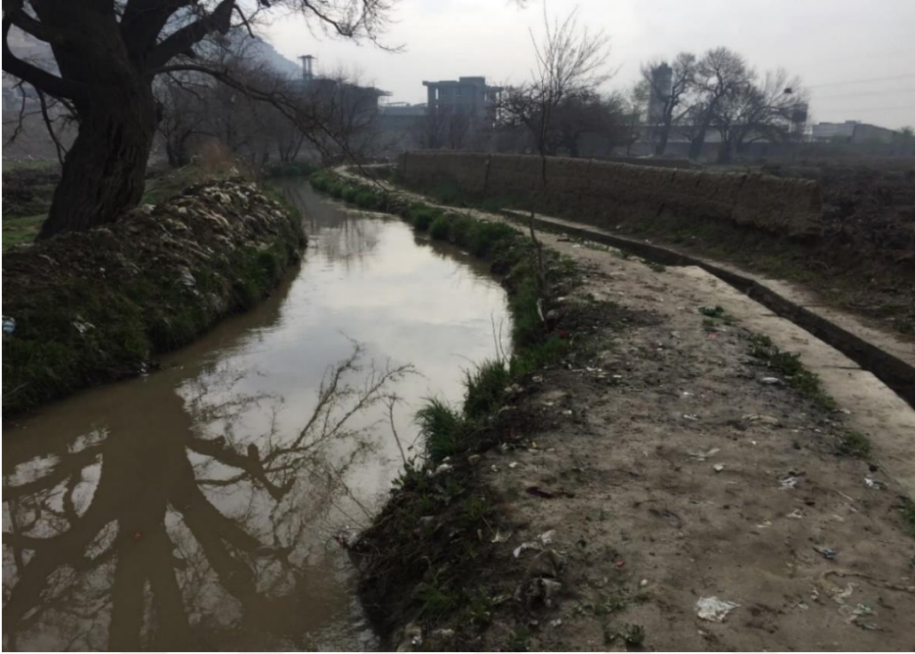
Şekil 4.5. Dehsabz ilçesinde ilkel sulama kanalının yanında verimli su kullanımı için devlet tarafından yapılan sulama kanalından bir görünüm
