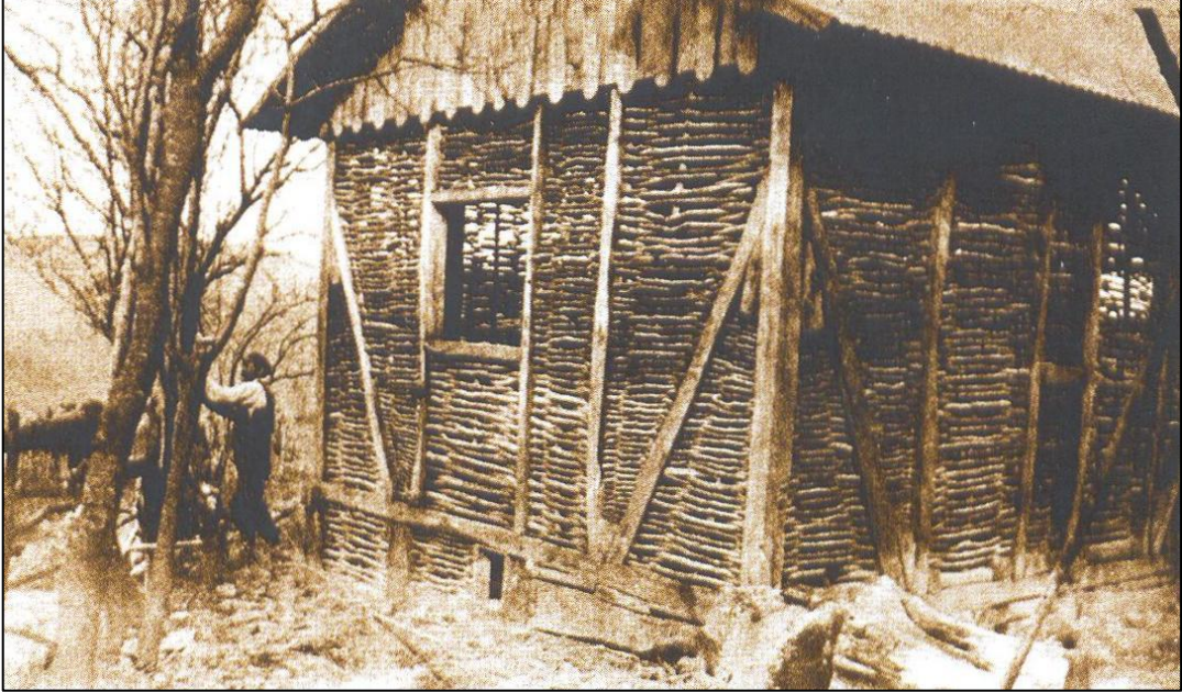
4: Polonezköy’deki ilk evlerin inşaat aşaması.
