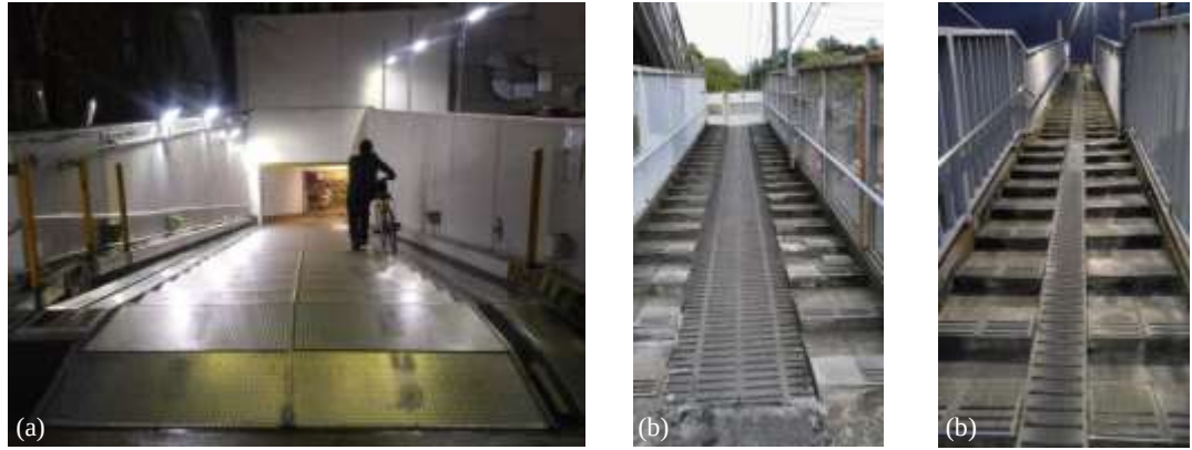
Şekil 2.11. Chiba (Japonya)'da (a) bisiklet rayı ve (b) bisiklet rampası (Orijinal 2018)
