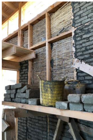
Şekil 4.34. Kadıovacık Biyoevi kerpiç duvar imalatı ve teknik çizimi (Yapı Biyolojisi ve Ekolojisi Enstitüsü, 2023b)
