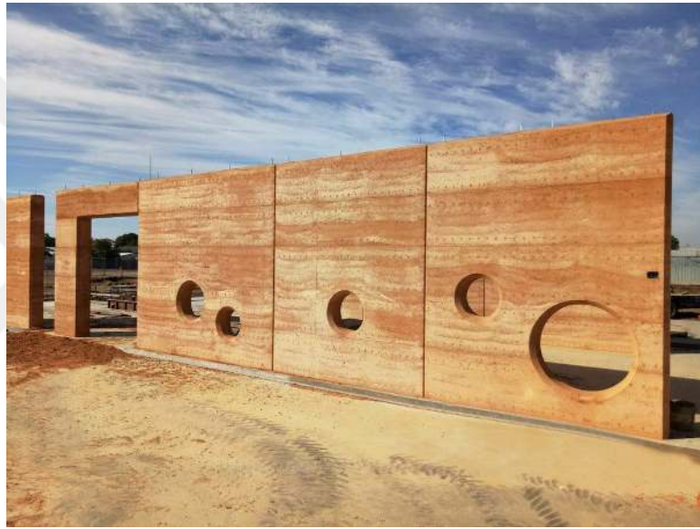
Şekil 4.36. Sıkıştırılmış toprak duvar (Rammed Earth Enterprises, 2019)
