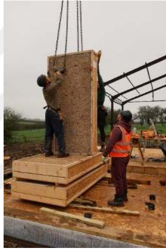
Şekil 4.28. Kenevir panel yerleştirme süreci (Gormley, 2019a)
