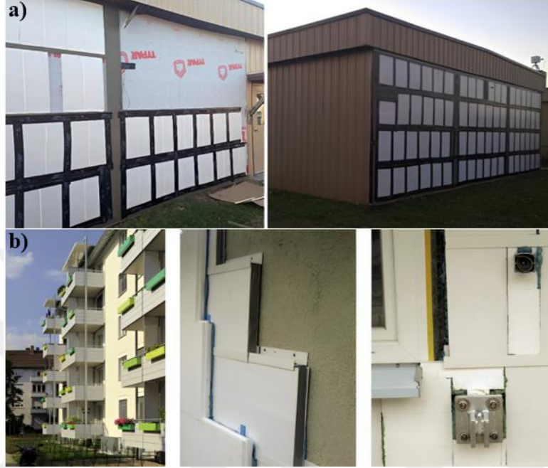
Şekil 2. a) Dış duvarların enerji açısından verimli bir şekilde yeniden donatılması için düşük maliyetli VIP'ler (Biswas vd., 2019) ve b) EPS köpüklerle VIP'lerin hibrit dış duvar izolasyonu (Johansson vd., 2014a)
