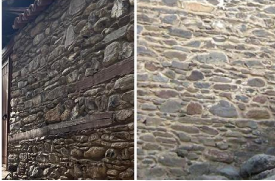
Şekil 4.7. Birgi konutlarında kullanılan kayrak taşı ve örgü tarzı
