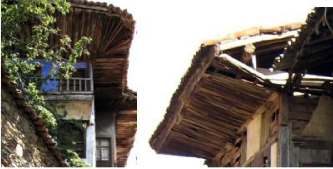
Şekil 4.11. Birgi geleneksel konutlarında yukarı doğru eğimli inşa edilen çatılara örnekler
