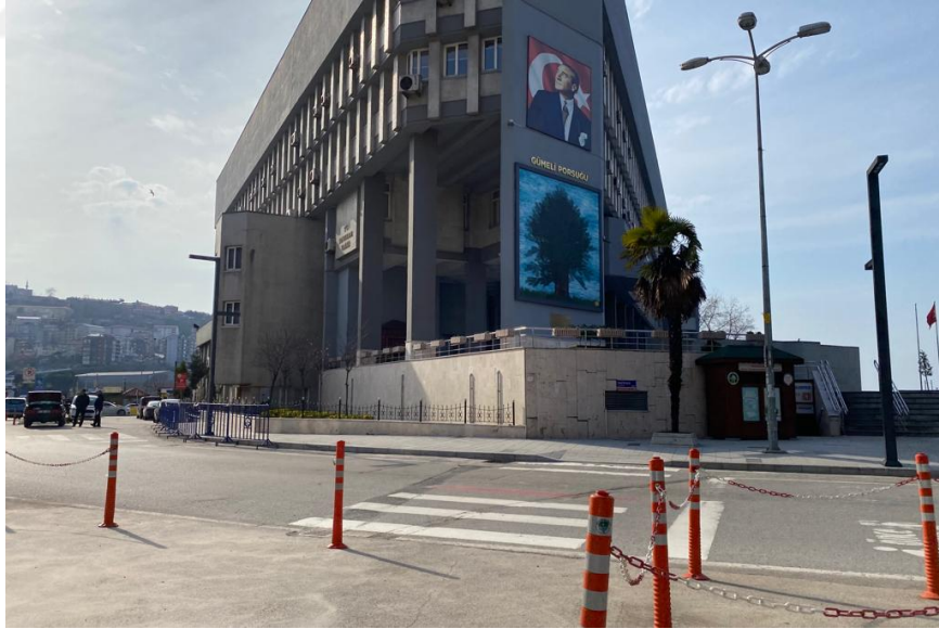
Şekil 4. 12: Zonguldak İl Valiliği'nin cephesindeki mozaik (Şahin, 2022).
