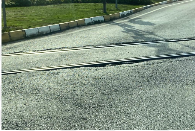
Şekil 4. 21: Kesişen karayolu ve demiryolu aksı
