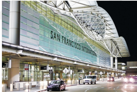
Şekil 2. 15: San Francisco'daki T2 Havaalanı (URL-11, 2015).
