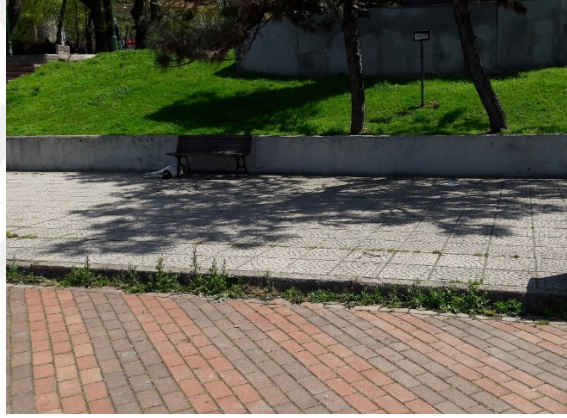
Şekil 4. 49: Sahil yolundaki döşeme (Şahin, 2022).
