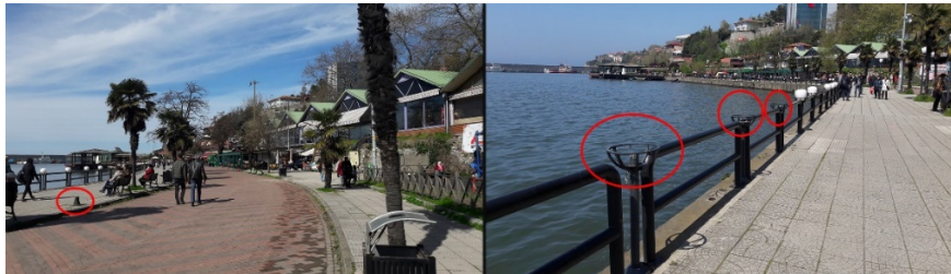
Şekil 4. 67: Eksik olan aydınlatmaların görünümü (Şahin, 2022).
