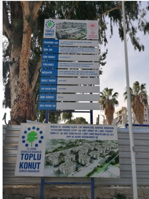
Şekil 7.47. Çay Mahallesi Kentsel Dönüşüm ve Gelişim Proje Alanı Şantiye Girişi.
