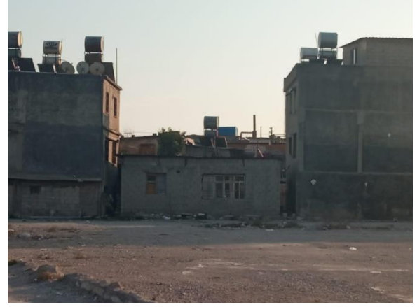
Şekil 7.43. Atatürk Bulvarı (D400) Üzerinden Çay Mahallesi Görüntüsü.
