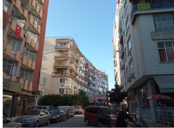
Şekil 7.10. Bahçe Mahallesi 4604 No'lu Sokaktan Bir Görüntü.
