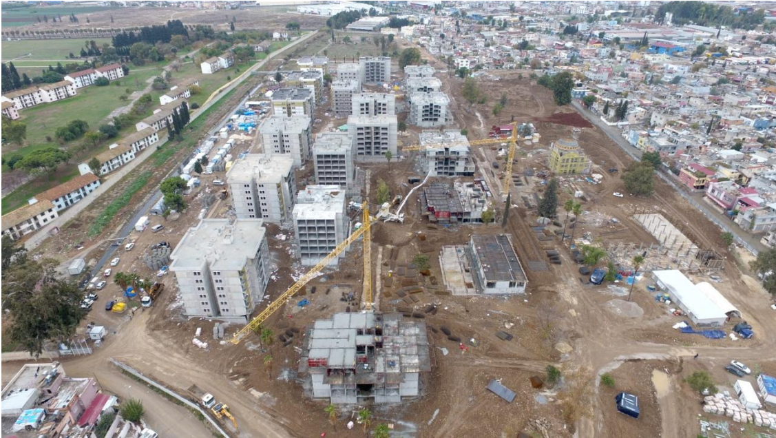
Şekil 7.51. ay Mahallesi Kentsel Dönüşüm ve Gelişim Proje Alanından Bir Görüntü.
