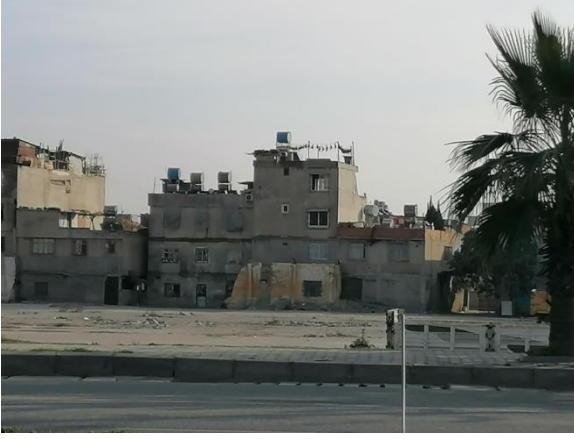
Şekil 7.42. Atatürk Bulvarı (D400) Üzerinden Çay Mahallesi Görüntüsü.
