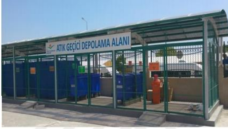
Şekil 2.10. Atık geçici depolama alanı
