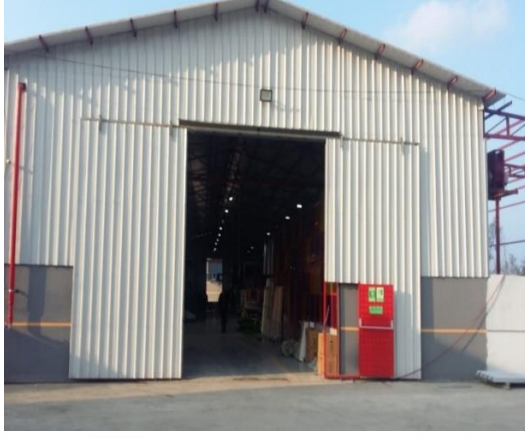
Resim 1. Tesisin Dış Görünüşü
