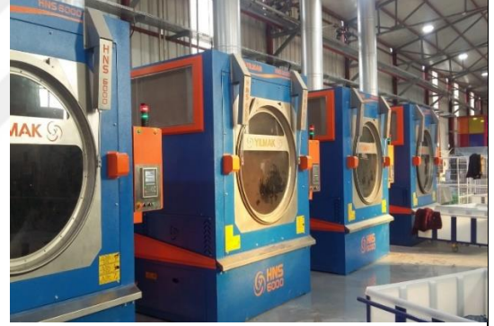
Resim 4. Tesisin İç Görünüşü (Üretim Sahası)
