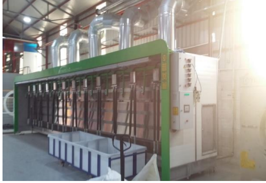
Resim 3. Tesisin İç Görünüşü (Üretim Sahası)
