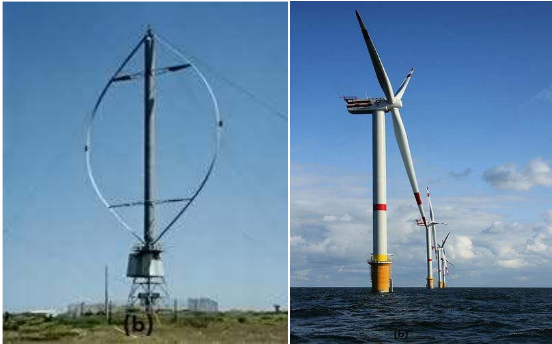
Resim 2-1. a) Düşey eksenli rüzgar türbin modeli [49] b) Yatay eksenli rüzgar türbin modeli [49]
