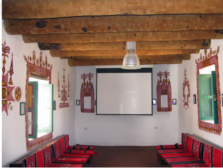
Şekil 3.14. Palmiye gövdelerinden yapılan tavan [30]
