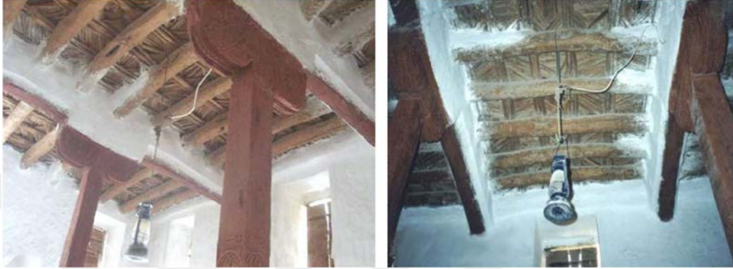
Şekil 3.7. Tavanı inşa etmek için Palmiye gövdelerinin kullanımı [27]
