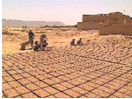
Şekil 3.4. Kilin güneş altında kurutulması, Şibam [31]
