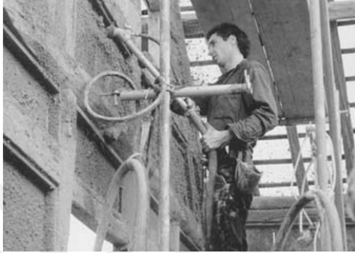
Şekil 2.17. Talaş ile kil püskürtme cihazı [19].
