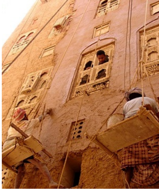
Şekil 3.6. Duvarların dış yüzlerinin kille kaplaması [29]
