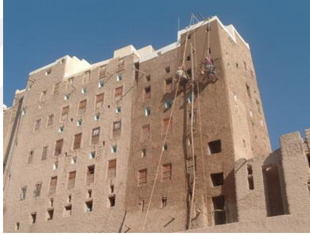
Şekil 3.9. Kıştan sonra bakım işlemleri ve aşınmış alanların yeniden kaplaması [29]
