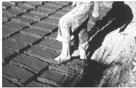
Şekil 2.4. Kil karışımını kalıplara sıkıştırma [19].
