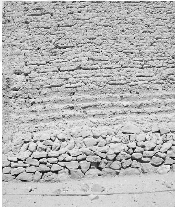
Şekil 3.15. Temel taşları ve üzeri kil duvarlar [33]
