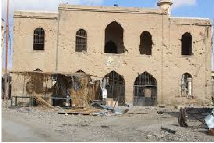
Şekil 4.30. Rakka şehri bombalandıktan sonra müzenin durumu, 2017 [51].
