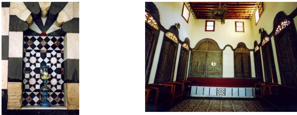
Şekil 92. Al-Ağa Restoranı. Niş
