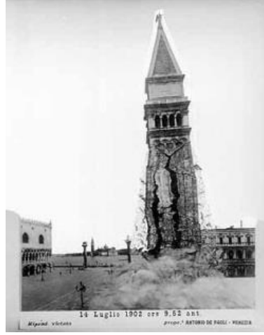
Şekil 26. July 14, 1902 kule çökmesi (URL-34, 2021)
