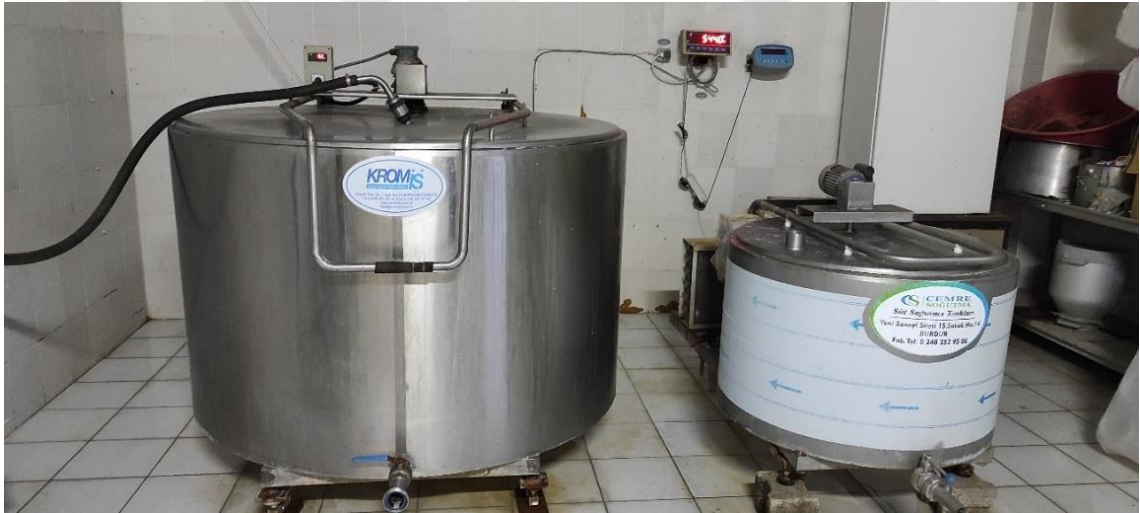
Şekil 3.13. ISUBÜ işletmesi, süt soğutma tankı
