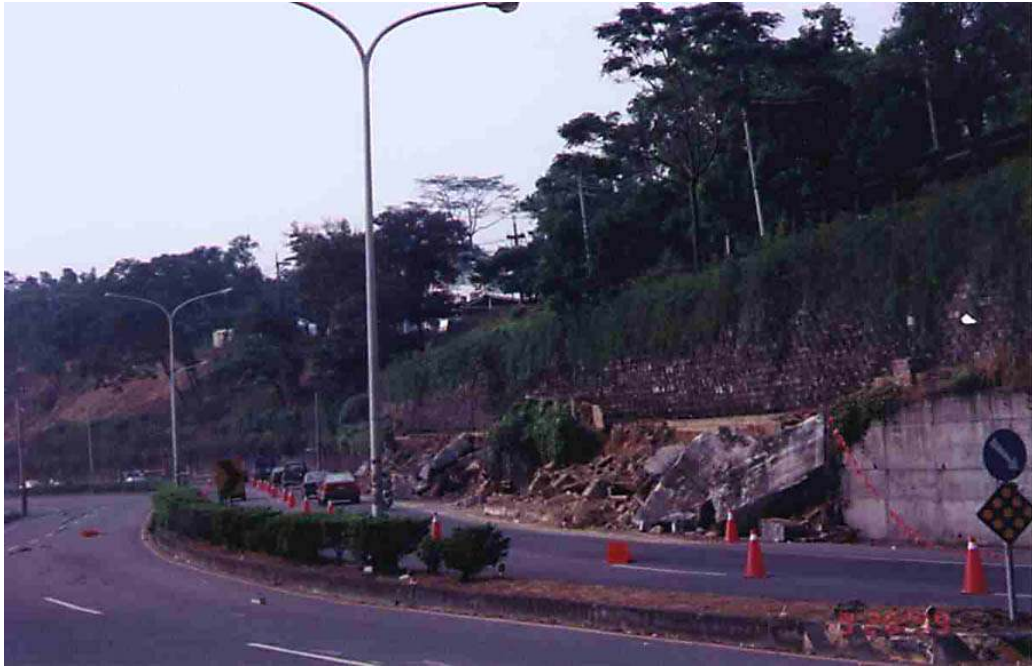
Şekil 4.12 Yıkılmış bir istinat duvarı örneği ( www.earthscape.org/r1/uac01/uac01.html )
