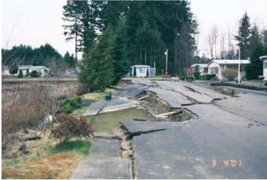
Şekil 4.8 Bir yanal akma örneği ( http://earthquake.usgs.gov/ )
