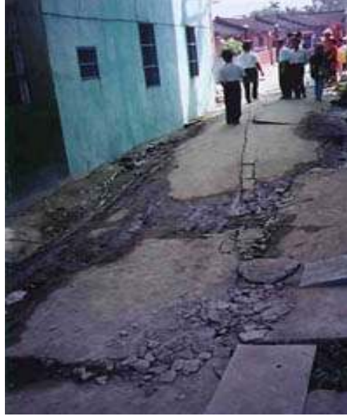
Şekil 4.9 Sıvılaşma etkisiyle zemin yüzünde meydana gelen bir çökme örneği ( www.earthscape.org/r1/uac01/uac01.html )
