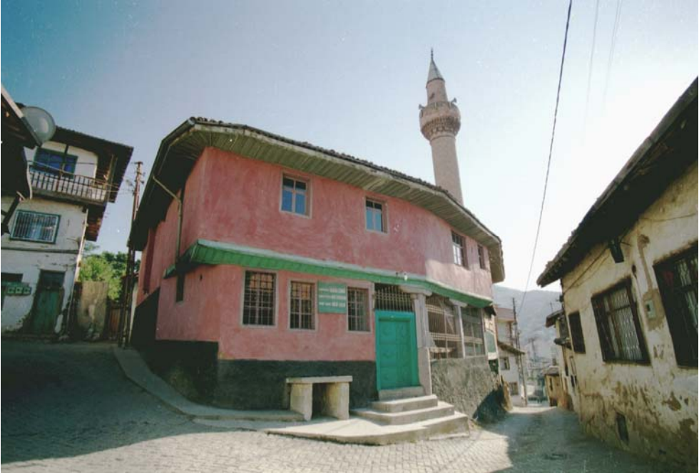
Fotoğraf-116: Tokat Kaya Cami (Onarım Öncesi)
