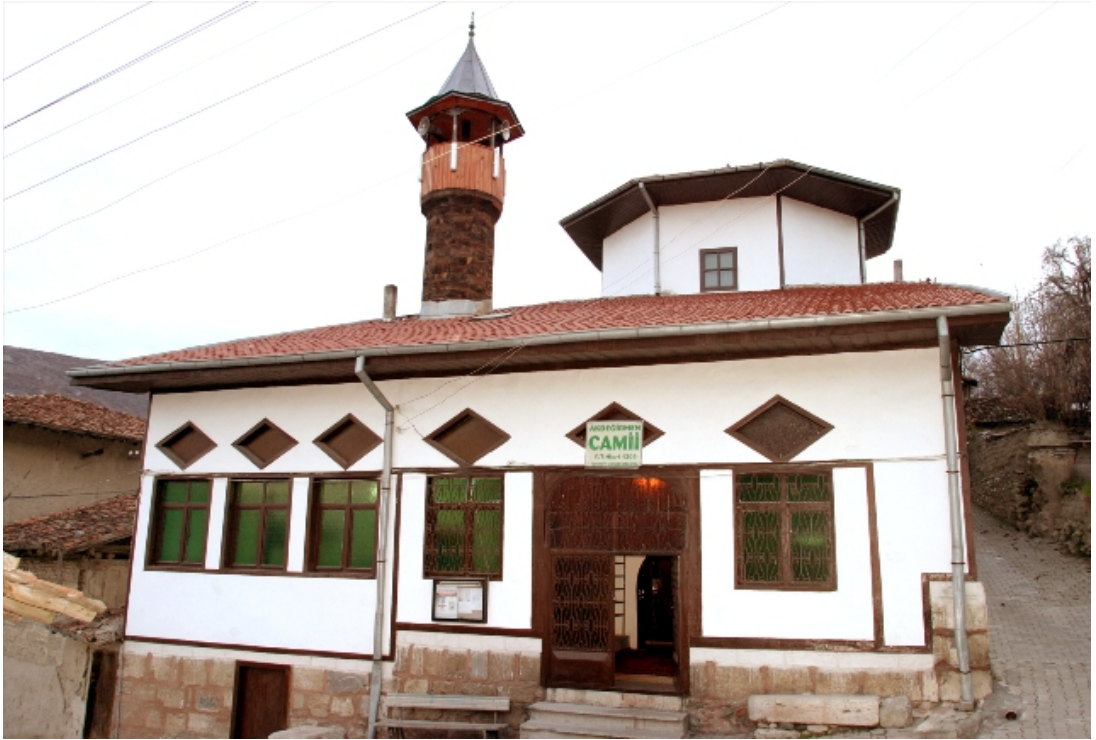
Fotoğraf-71: Tokat Akdeğirmen Cami (Onarım Sonrası)
