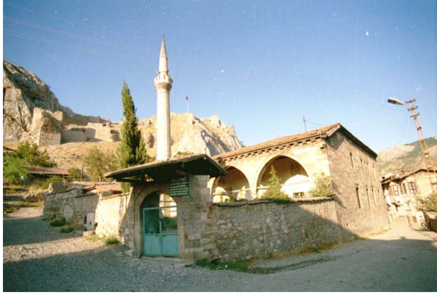
Fotoğraf–147: Tokat Ulu Cami (Onarım Öncesi)
