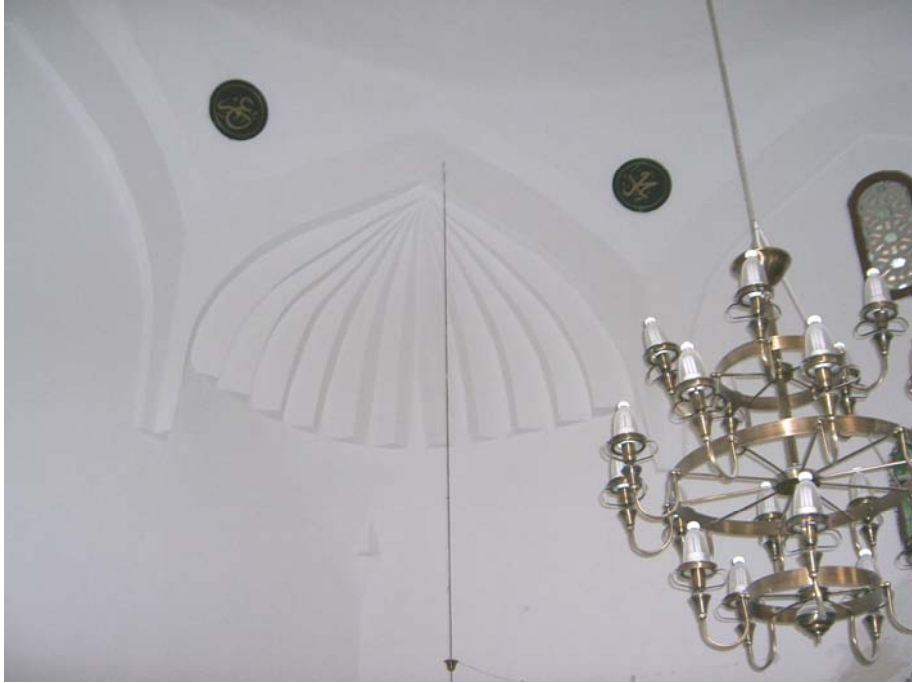
Fotoğraf–108: Tokat Hacı Behzat Camii Kubbeye Geçiş Elemanı
