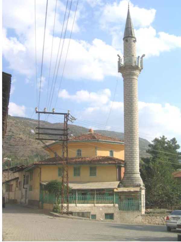
Fotoğraf-93: Tokat Devegörmez Cami (Onarım Öncesi)
