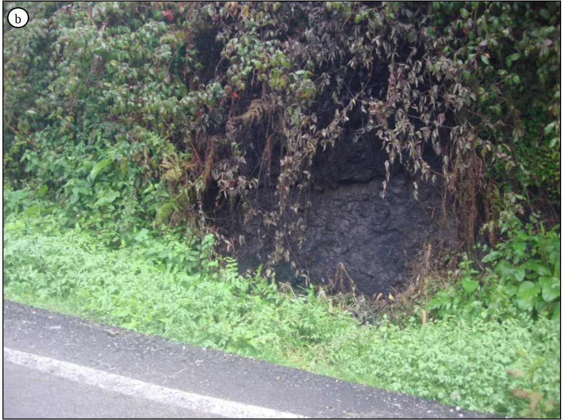
Şekil 3. Çağlayan Formasyonu'na ait aglomeranın mevcut yol şevindeki görünümü
