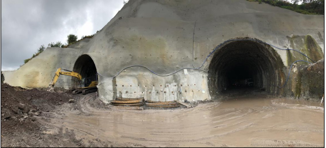
Şekil 2. T3 Tüneli'nin giriş bölümü
