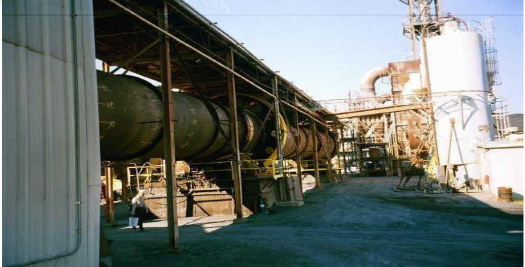
Şekil 1.13. Döner Fırın Tesisinin Görünümü
