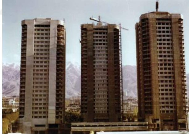
Şekil 5.24. İnşaat sırasında Eskan Kuleleri, Nisan 1977 [68]
