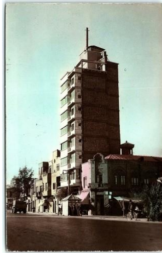
Şekil 5.14. Tahran'daki ilk yüksek katlı bina [65]
