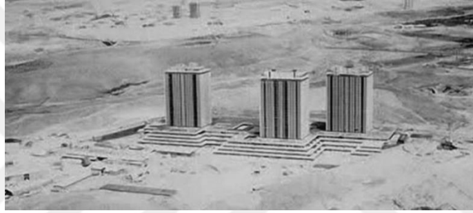
Şekil 6.11. ASP Kuleleri yeni inşa edildiğinde [67].
