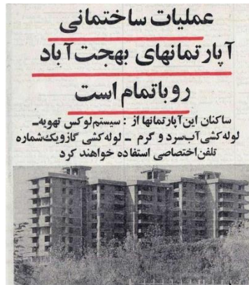
Şekil 5.18. II. Pehlevi dönemi gazetesinde, Behjat Abad Kompleksi sakinlerinin sıcak ve soğuk su, gaz ve özel telefon kullanabilecekleri açıklanmaktadır [36].
