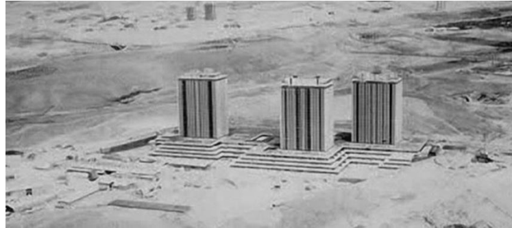
Şekil 5.22. ASP Kuleleri yeni inşa edildiğinde [67].
