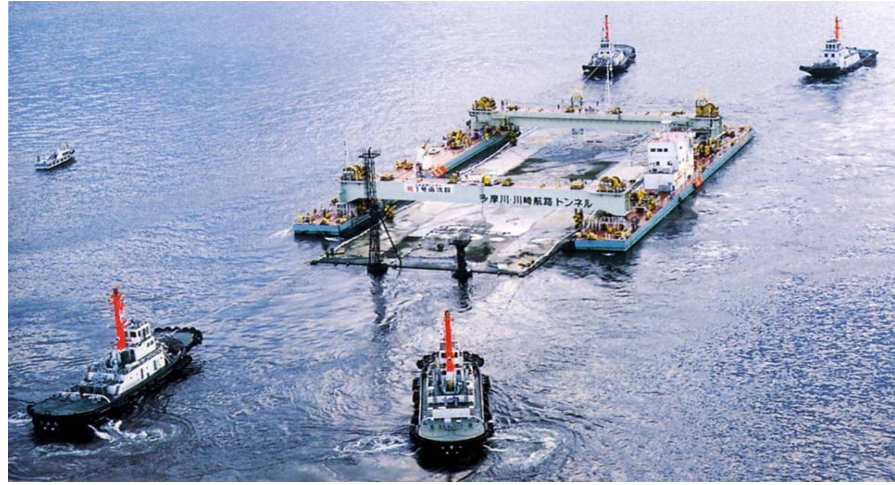
Şekil 4.15 Batırma tüp inşaat metodu ( www.marmaray.com.tr )
