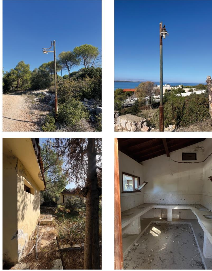
Şekil 4.13. Aydınlatmalar ve yapıların bakım durumu görünüm
