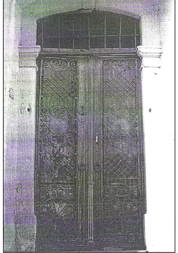
Fotoğraf 6.13 Bergama Evlerinin S ve C kıvrımlı demir parmaklı giriş kapıları ve metal konsollu balkonları (Pilehverian,1995:39)
