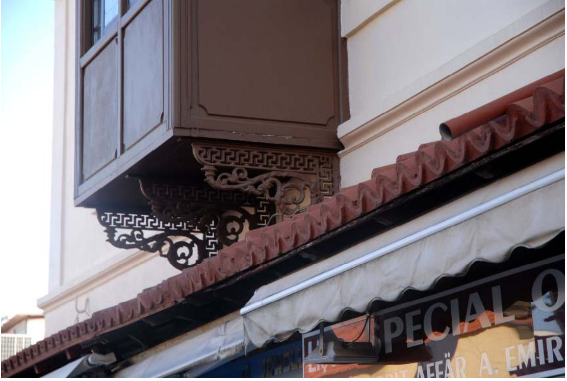
Fotoğraf 5.1 Katalog 17'deki evin çıkmasının metal döküm furuşu
