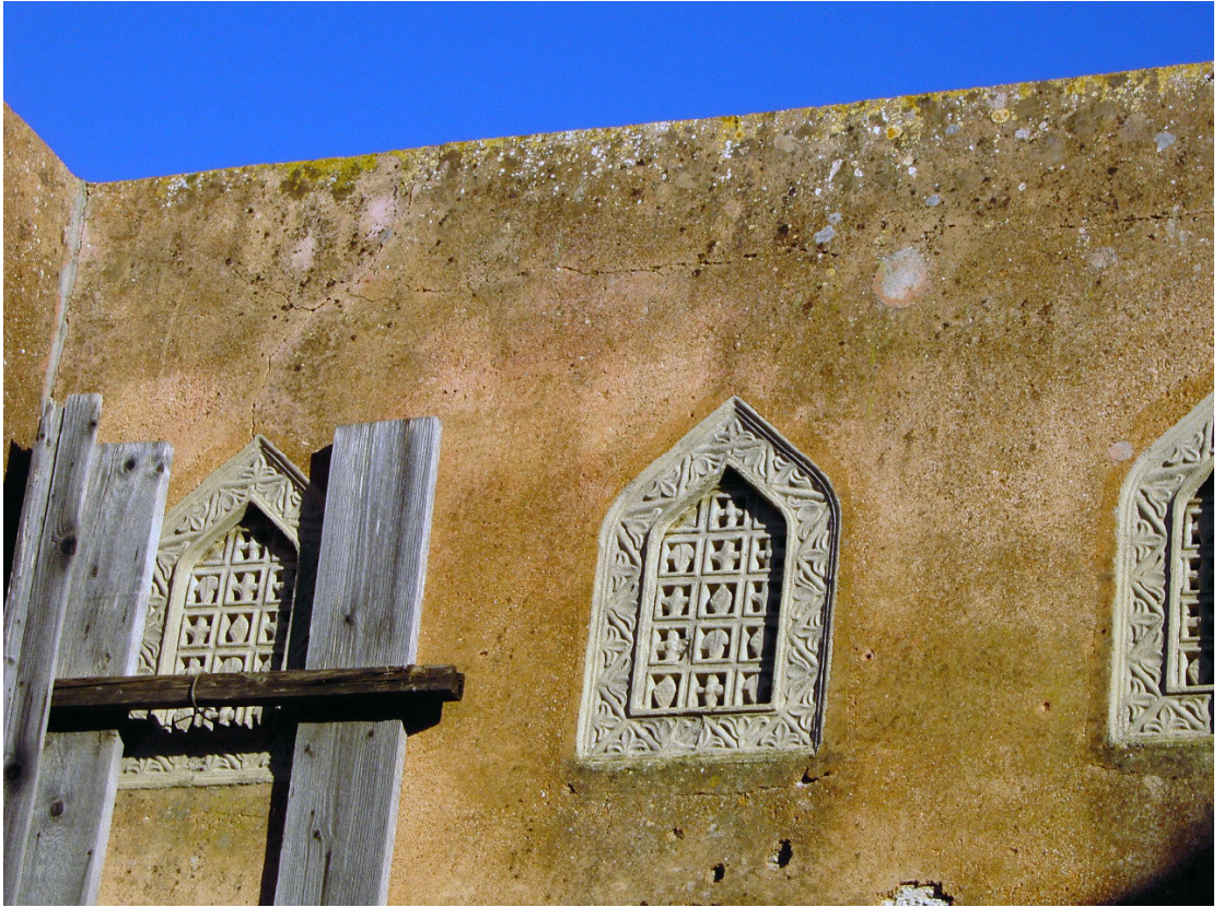
Fotoğraf 5.13 Katalog 10'da alçı tepe pencereleri
