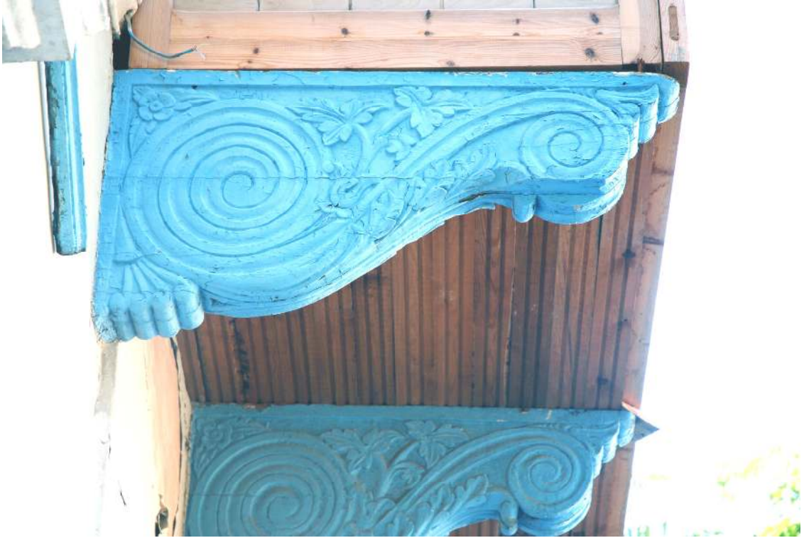
Fotoğraf 5.2 Katalog 13'deki evde bitkisel motifli ahşap çıkma taşıyıcısı
