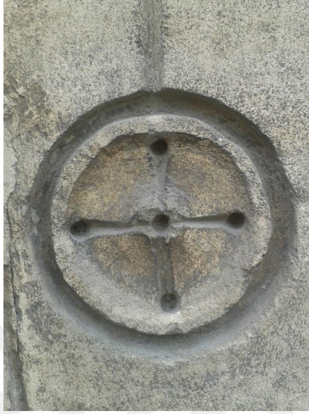
Fotoğraf 87 Mithatpaşa Mesleki ve Teknik Anadolu Lisesi Kuzey Cephede Yer Alan Alt Kat Pencereleeri Arasındaki Pilastrların Yanında Bulunan Süslemelerden Detay
