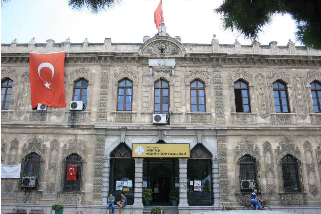
Mithatpaşa Mesleki ve Teknik Anadolu Lisesi Kuzey Cephesinden Görünüş
