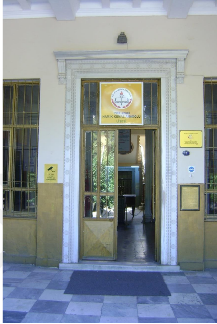
Fotoğraf 15 Namık Kemal Lisesi Ana Binasının Doğu Cephesindeki Giriş Kapısı ve Süslemeleri
