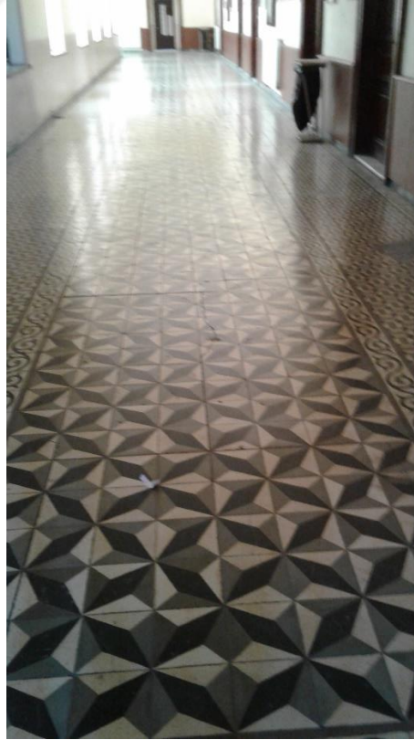
Fotoğraf 118 Mithatpaşa Mesleki ve Teknik Anadolu Lisesi Birinci Kat Batı Koridoru
