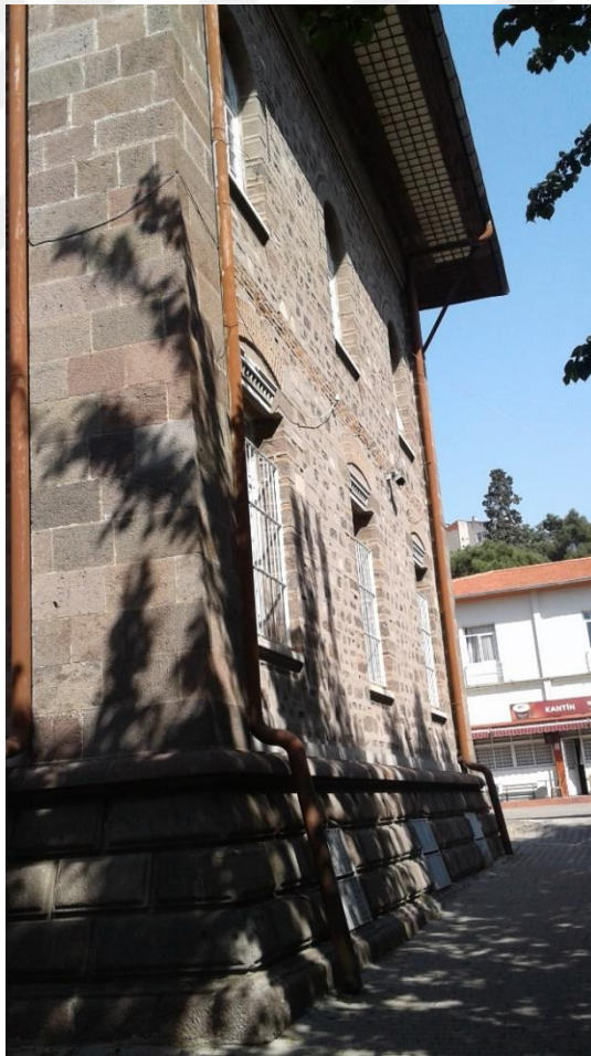
Fotoğraf 192 İzmir Kız Lisesi Kuzey Kanadın Batı Cephesi
