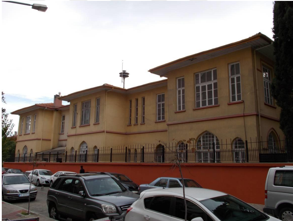
Fotoğraf 266 Karşıyaka İmam Hatip Ortaokulu Kuzey Cephe Eski Hali
