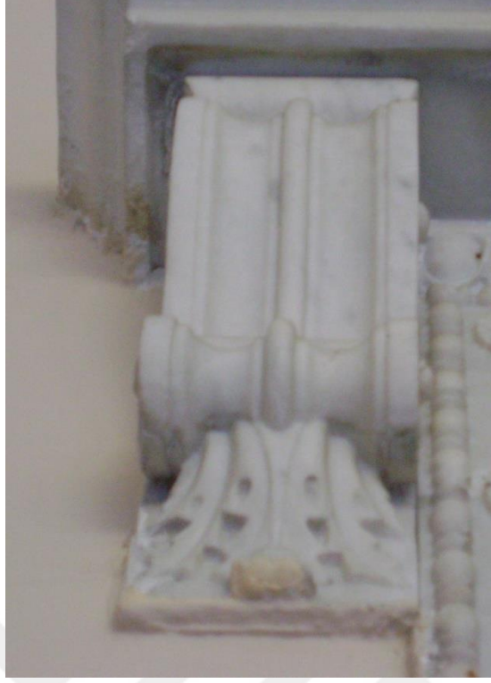
Fotoğraf 17 Namık Kemal Lisesi Ana Binanın Doğu Cephesindeki Giriş Kapısı Üzerindeki Konsollardan Detay
