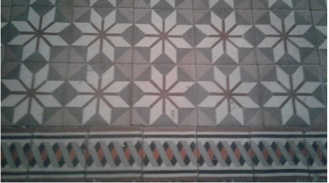
Fotoğraf 122 Mithatpaşa Mesleki ve Teknik Anadolu Lisesi Birinci Kat Kuzey Koridoru Karo Döşemeden Ayrıntı
