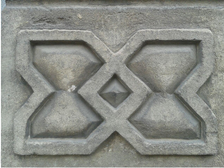
Fotoğraf 89 Mithatpaşa Mesleki ve Teknik Anadolu Lisesi Kuzey Cephede Girişte Yer Alan Kolonların Yanında Bulunan Pilastr Yüzeyinden Detay
