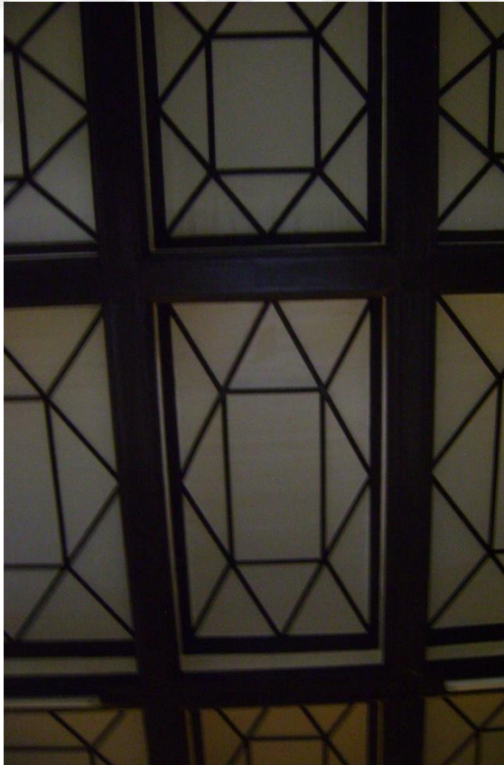
Fotoğraf 248 İzmir Kız Lisesi Birinci Katta Merdivenli Bölümün Ahşap Tavanından Detay
