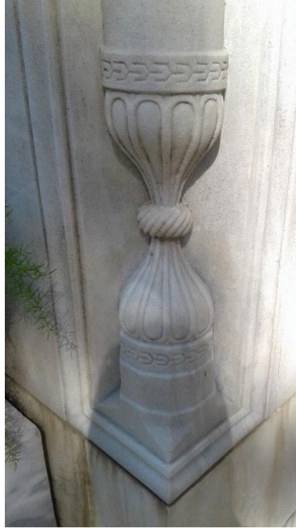
Fotoğraf 210 İzmir Kız Lisesi Kuzey Cephenin Köşesinde Yer Alan Payelerin Üzerindeki Sütunçeden Detay
