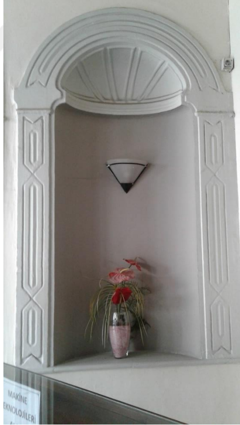
Fotoğraf 92 Mithatpaşa Mesleki ve Teknik Anadolu Lisesi Giriş Holünün Doğu ve Batı Duvarında Yer Alan Nişlerden Detay
