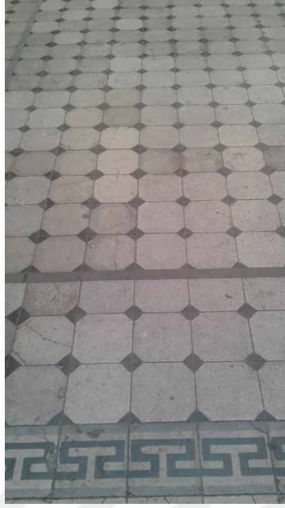
Fotoğraf 101 Mithatpaşa Mesleki ve Teknik Anadolu Lisesi Zemin Kat Şeref Merdiveni Bölümünün Güneyinde Yer Alan Avlunun Karo Desenli Zemini
