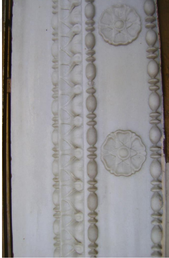
Fotoğraf 18 Namık Kemal Lisesi Ana Binanın Doğu Cephesindeki Giriş Kapısı Sövelerinde Yer Alan Süsleme Detayları
