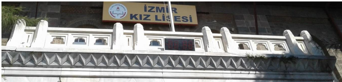
Fotoğraf 212 İzmir Kız Lisesi Kuzey Cephedeki Girişin Üzerinde Yer Alan Balkon Korkuluğu ve Süslemeleri
