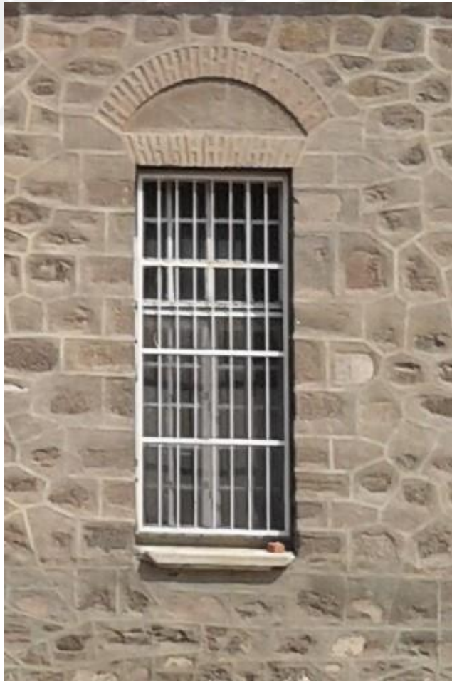
Fotoğraf 204 İzmir Kız Lisesi Kuzey ve Güney Kanadın Güney Cephesindeki Pencerelelerin Etrafındaki Tuğla Süsleme
