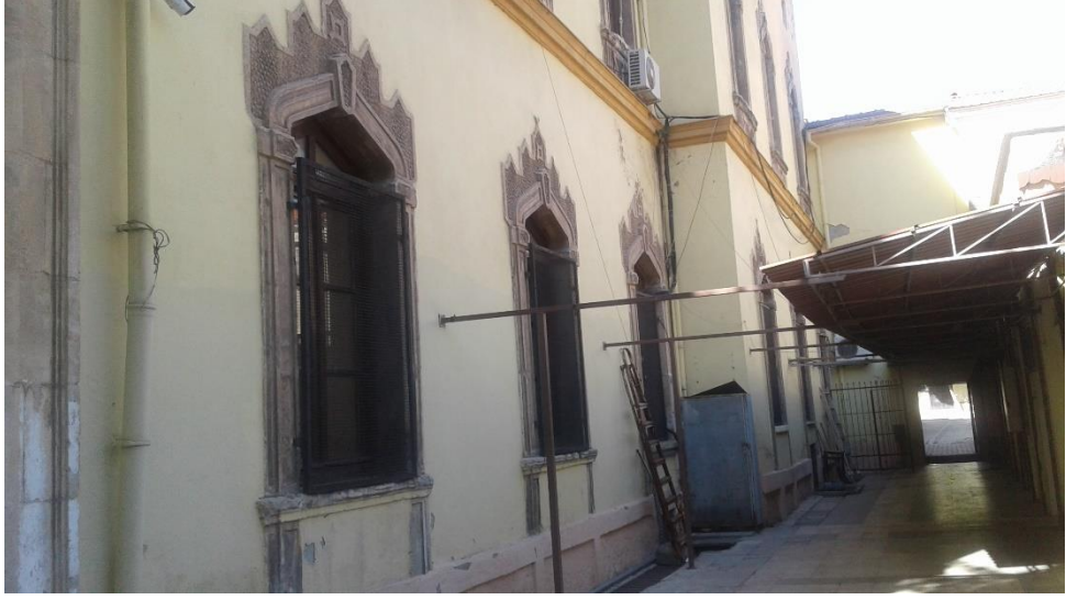
Fotoğraf 73 Mithatpaşa Mesleki ve Teknik Anadolu Lisesi Güney Cephedeki Alt Kat Pencerelelerinin Alt Tarafındaki Düşen Süslemeler
