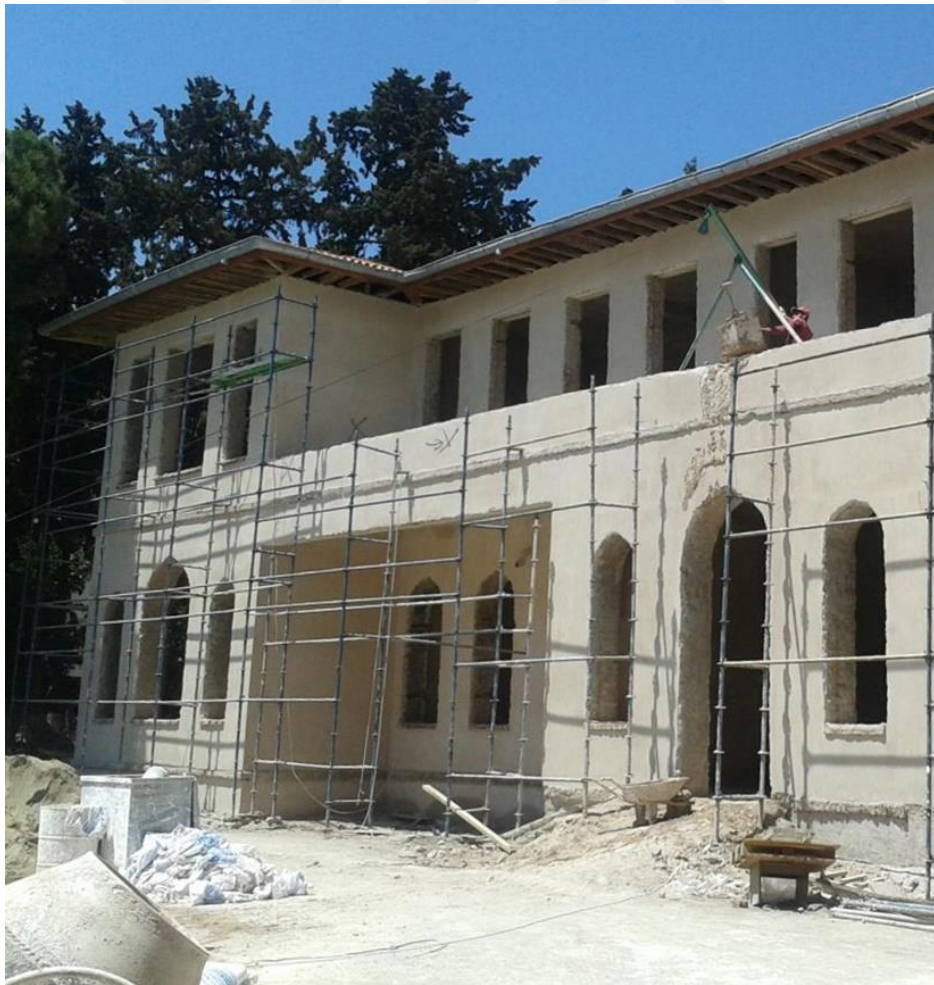
Fotoğraf 270 Karşıyaka İmam Hatip Ortaokulu Güney Cephe Kapı ve Pencere Açıklıkları
