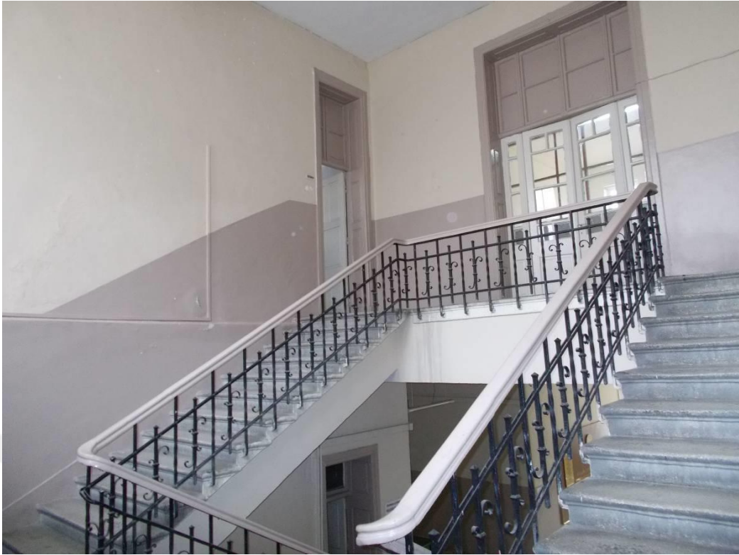
Fotoğraf 279 Karşıyaka İmam Hatip Ortaokulu Zemin Kattan Birinci Kata Ulaşımı Sağlayan Merdivenler
