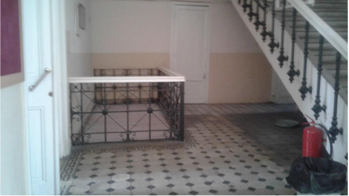
Fotoğraf 166 Atatürk Lisesi Sütunlu Galerinin Batısında Yer Alan B Koridorundaki Spor Odasına Geçişi Sağlayan Kapı ve Üst Kata Çıkışı Sağlayan Merdivenler
