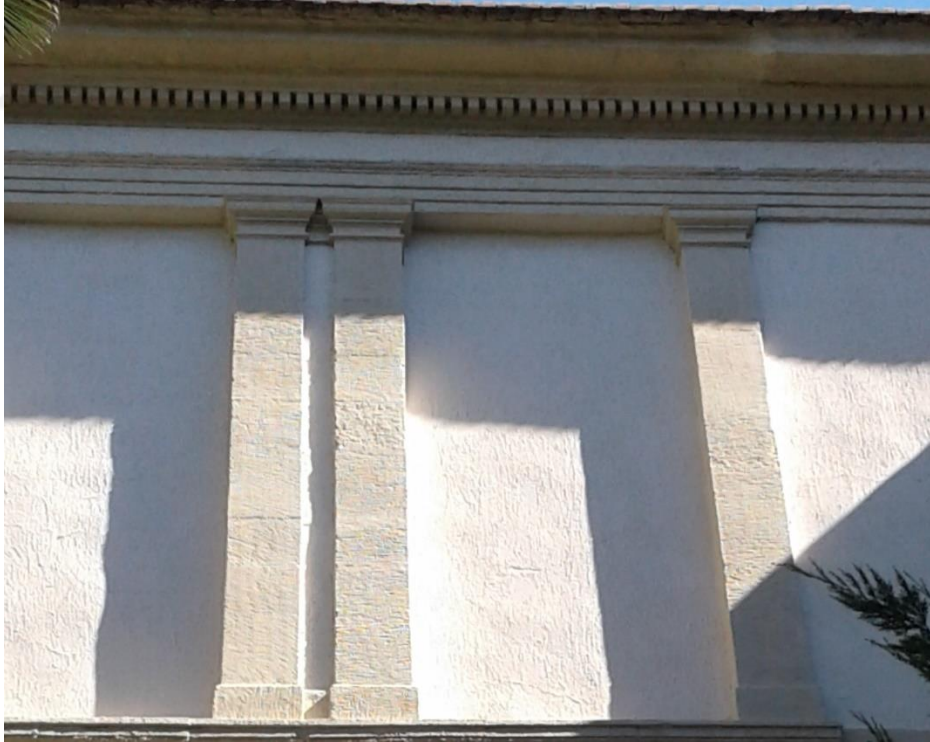
Fotoğraf 6 Namık Kemal Lisesi Cephelerdeki Silmeler, Pilastrlar ve Kornişler
