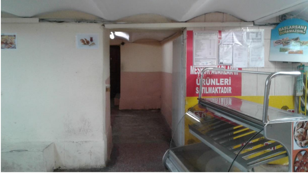
Fotoğraf 95 Mithatpaşa Mesleki ve Teknik Anadolu Lisesi Dikdörtgen Planlı Bodrum Katının Batı Duvarında Bulunan Koridor Ve Merdiven
