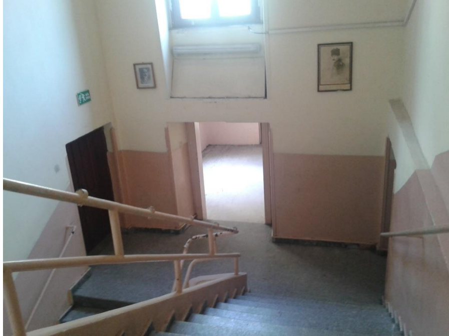
Fotoğraf 112 Mithatpaşa Mesleki ve Teknik Anadolu Lisesi Zemin Katın Güneydoğusundaki Merdivenden Ek Binalara Geçiş
