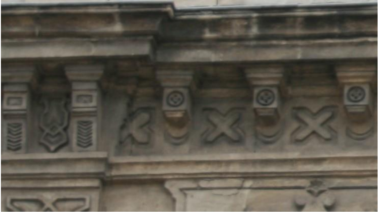
Fotoğraf 78 Mithatpaşa Mesleki ve Teknik Anadolu Lisesi Kuzey Cephede Yer Alan Korniş ve Süslemelerden Detay
