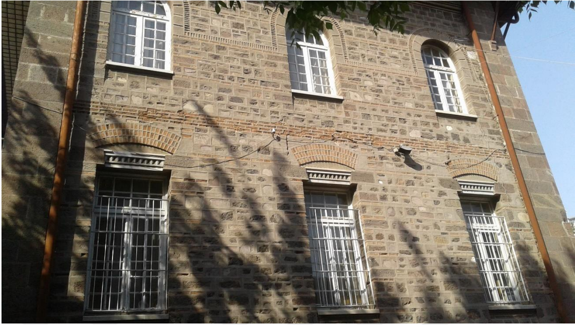
Fotoğraf 201 İzmir Kız Lisesi Kuzey Kanadın Doğu, Batı, Güney Cephelerindeki Üst ve Alt Kat Pencere Aralarındaki Tuğla Dizisi
