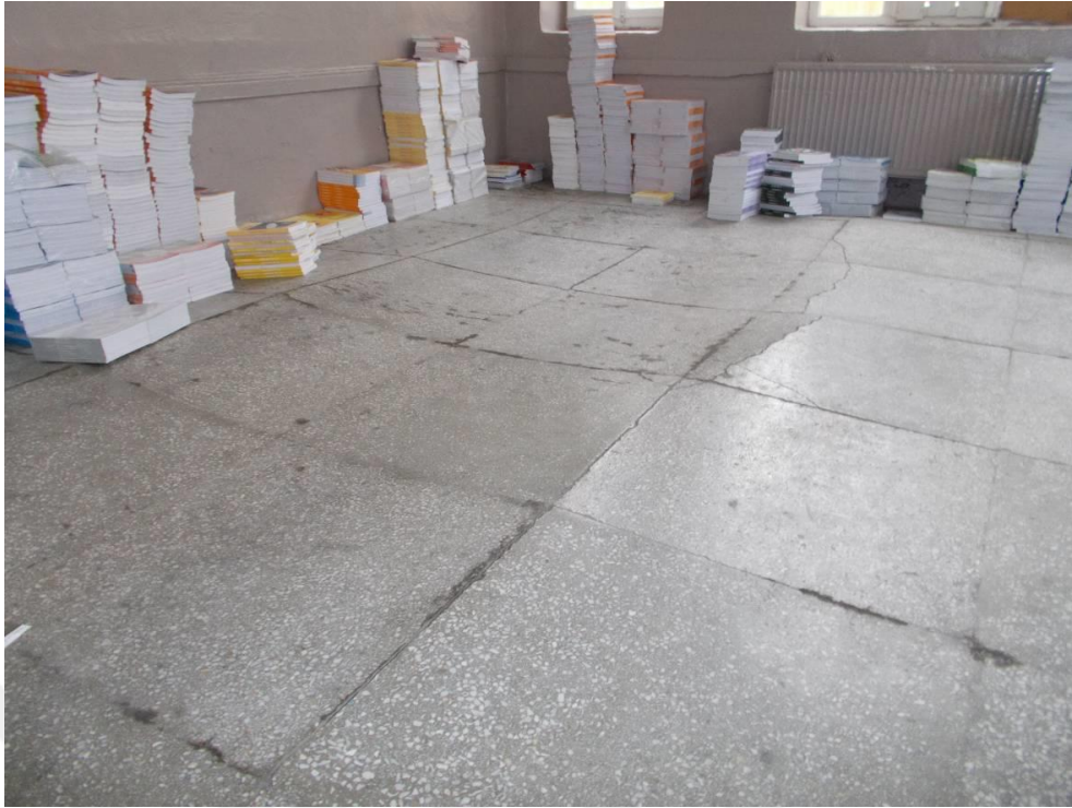
Fotoğraf 277 Karşıyaka İmam Hatip Ortaokulu Zemin Kat Koridorunda Yer Alan Z09 Nolu Sınıfın Zemin Döşemesi
