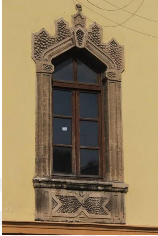
Fotoğraf 71 Mithatpaşa Mesleki ve Teknik Anadolu Lisesi Doğu, Batı ve Güney Cephede Yer Alan Pencere Etrafındaki Süslemelerden Görünüş
