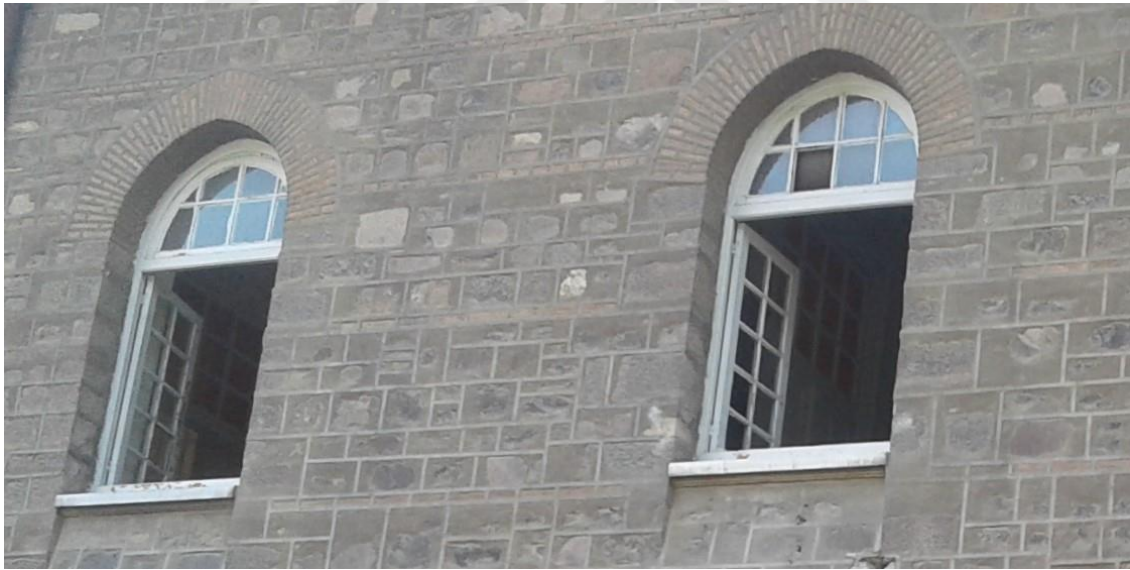
Fotoğraf 200 İzmir Kız Lisesi Kuzey Kanadın Güney Cephesindeki Üst Kat Pencereleri Etrafındaki Tuğla Süslemeler
