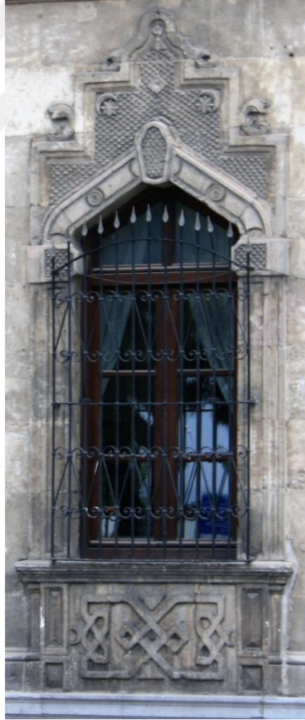
Fotoğraf 84 Mithatpaşa Mesleki ve Teknik Anadolu Lisesi Kuzey Cephede Yer Alan Alt Kat Pencereleleri Genel Görünüm
