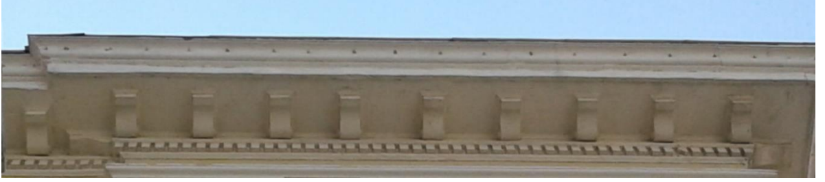
Fotoğraf 143 Atatürk Lisesi Kuzey Cephedeki Ana Kütlenin Saçak Kısımlarındaki Korniş, Konsol ve Dış Frizleri
