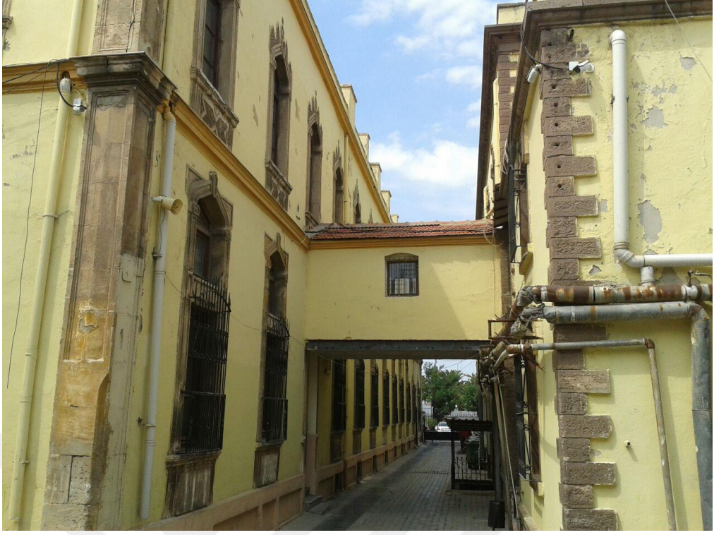
Fotoğraf 67 Mithatpaşa Mesleki ve Teknik Anadolu Lisesi Doğu Cephesinden Görünüş
