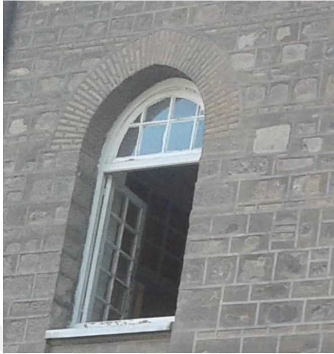
Fotoğraf 203 İzmir Kız Lisesi Kuzey Kanadın Güney Cephesindeki Üst Kat Pencerelelerinden Altı Tanesinin Etrafındaki Tuğla Süsleme
