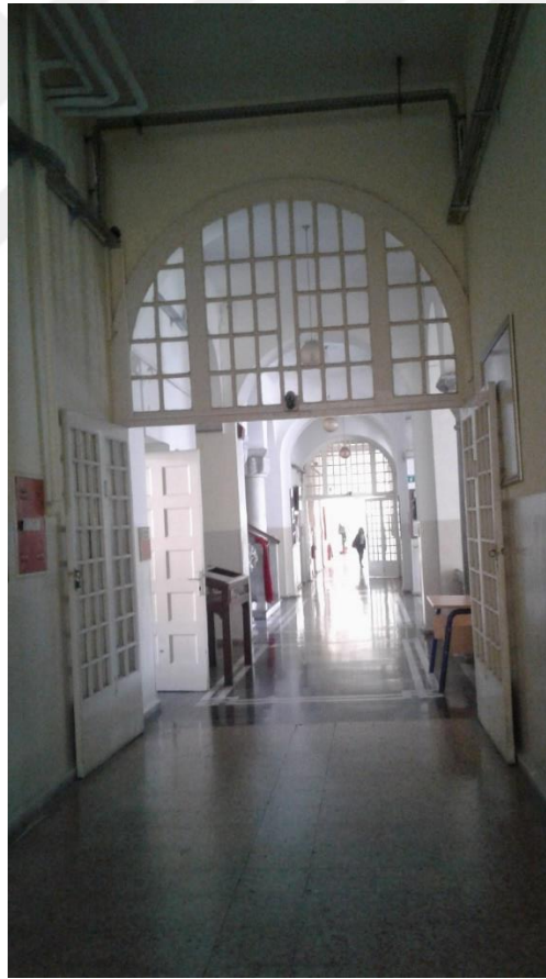
Fotoğraf 228 İzmir Kız Lisesi Zemin Katta Doğu ve Batıda Yer Alan Dikdörtgen Planlı Koridor
