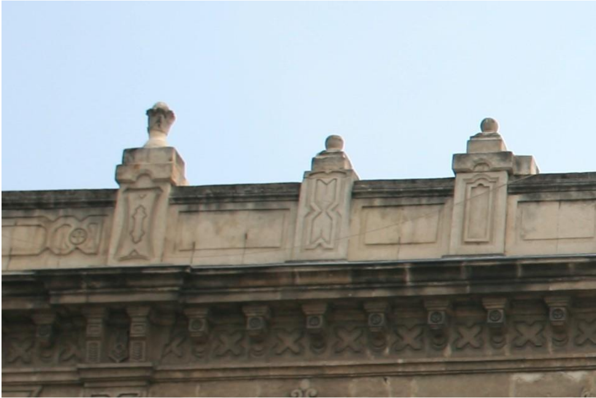
Fotoğraf 75 Mithatpaşa Mesleki ve Teknik Anadolu Lisesi Kuzey Cephede Yer Alan Parapet Duvarı ve Süslemeleri
