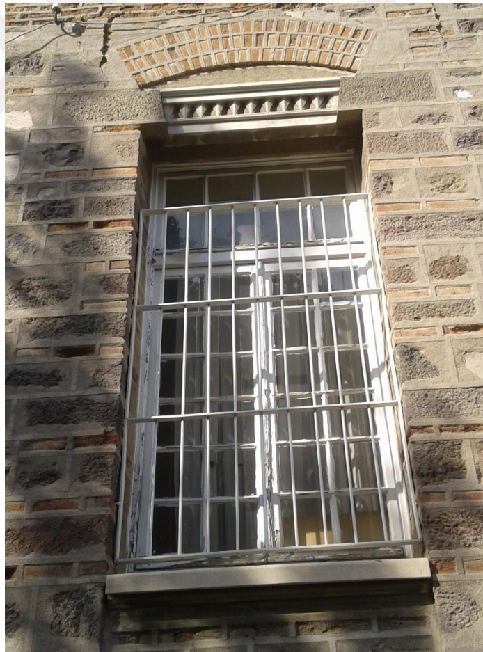
Fotoğraf 202 İzmir Kız Lisesi Kuzey Kanadın Doğu, Batı, Güney Cephelerindeki Alt Kat Pencere Etrafındaki Mermer ve Tuğla Süslemeler
