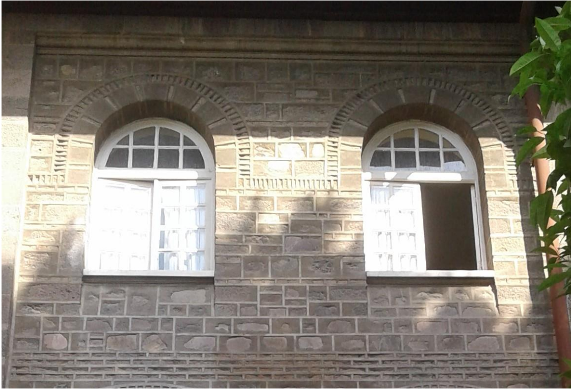
Fotoğraf 199 İzmir Kız Lisesi Kuzey Kanadın Doğu, Batı ve Güney Cephelerinin Üst Kat Pencereleri Etrafında Bulunan Taş Süslemeler
