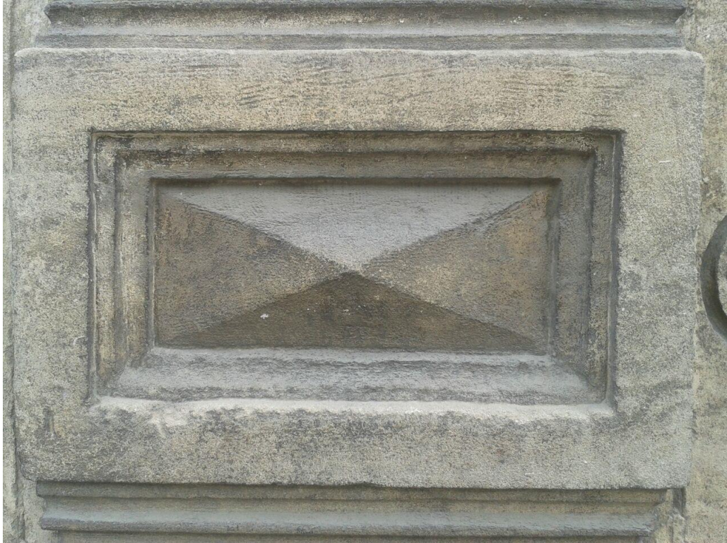
Fotoğraf 86 Mithatpaşa Mesleki ve Teknik Anadolu Lisesi Kuzey Cephede Yer Alan Alt Kat Pencereleeri Arasındaki Pilastr Yüzeyinde Bulunan Süslemelerden Detay
