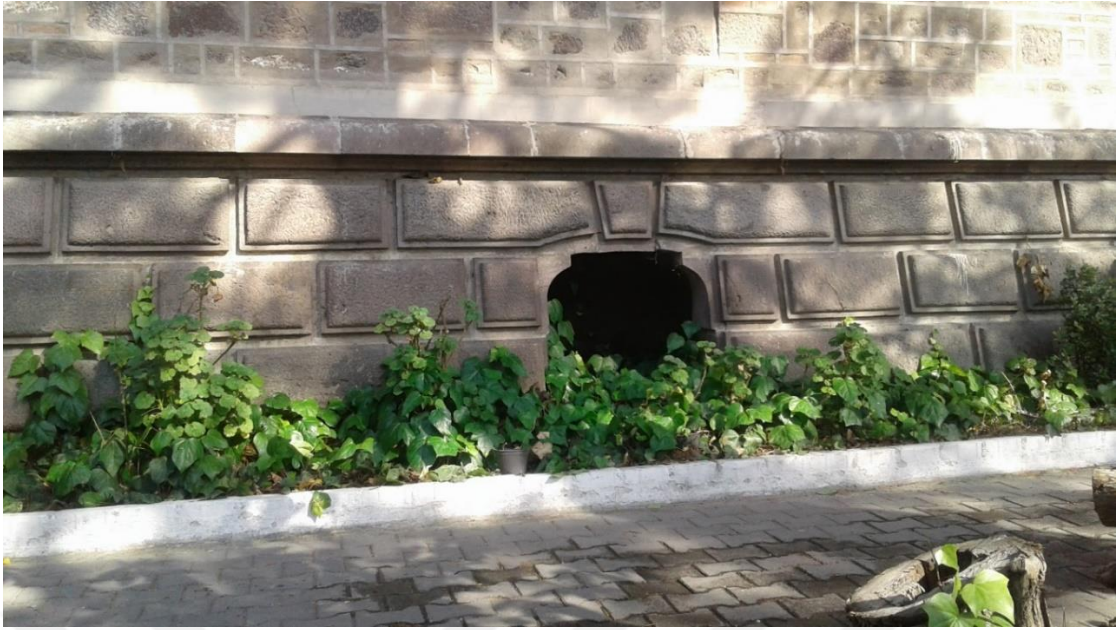
Fotoğraf 197 İzmir Kız Lisesi Kuzey Kanadın Doğu Cephesindeki Bodrum Katta Yer Alan Bursa Kemer Formunda Açıklık
