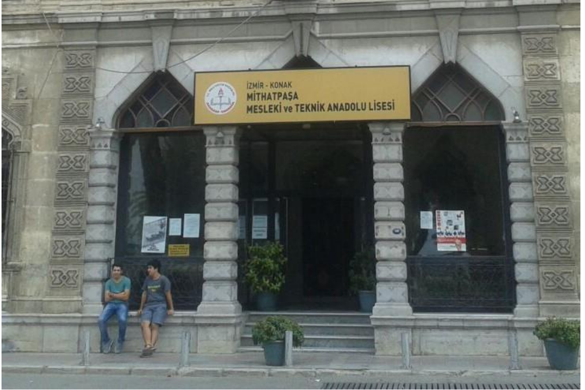
Fotoğraf 88 Mithatpaşa Mesleki ve Teknik Anadolu Lisesi Kuzey Cephe Kemerli Giriş
