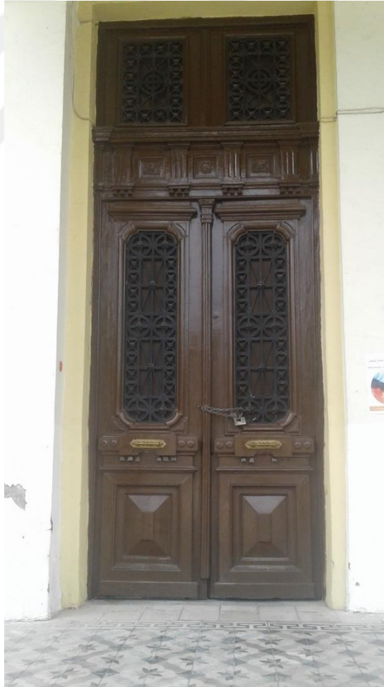
Fotoğraf 146 Atatürk Lisesi Kuzey Cephede Yer Alan Ahşap Kapılar
