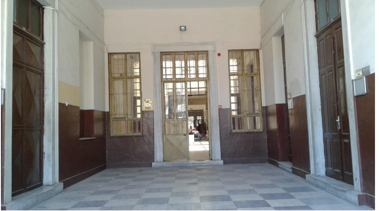
Fotoğraf 22 Namık Kemal Lisesi Güneyde Yer Alan Kütlenin Doğu ve Batı Duvarında Yer Alan Sınıflar
