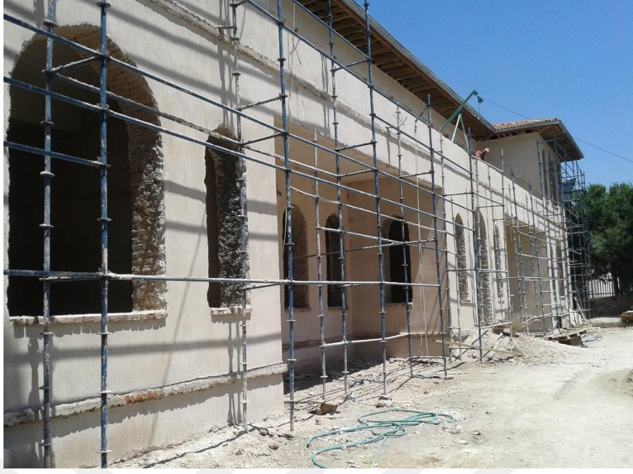
Fotoğraf 263 Karşıyaka İmam Hatip Ortaokulu Güney Cephe Restorasyon Hali
