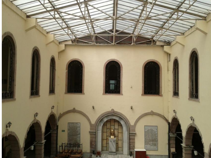
Fotoğraf 114 Mithatpaşa Mesleki ve Teknik Anadolu Lisesi Birinci Kattaki Dolaşım Koridorunun Doğu, Batı Güney Ve Kuzey Yönlerindeki Açıklıklar
