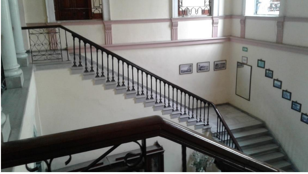
Fotoğraf 99 Mithatpaşa Mesleki ve Teknik Anadolu Lisesi Zemin Kat Şeref Merdiveni Bölümünün Duvarında Yer Alan Silmeler ve Pilastrlar
