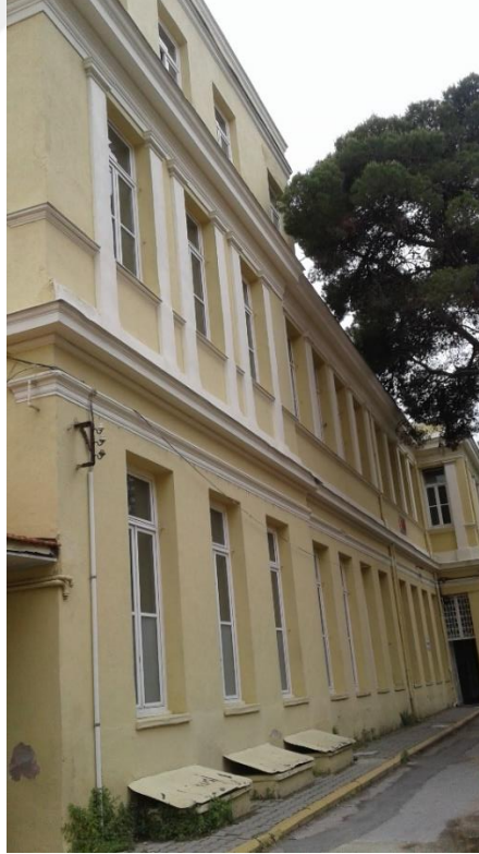
Fotoğraf 137 Atatürk Lisesi Güney Cephede Taşıntı Yapan Bölümün İki Yanında Bulunan Kolların Cephesinde Yer Alan Pencereleler
