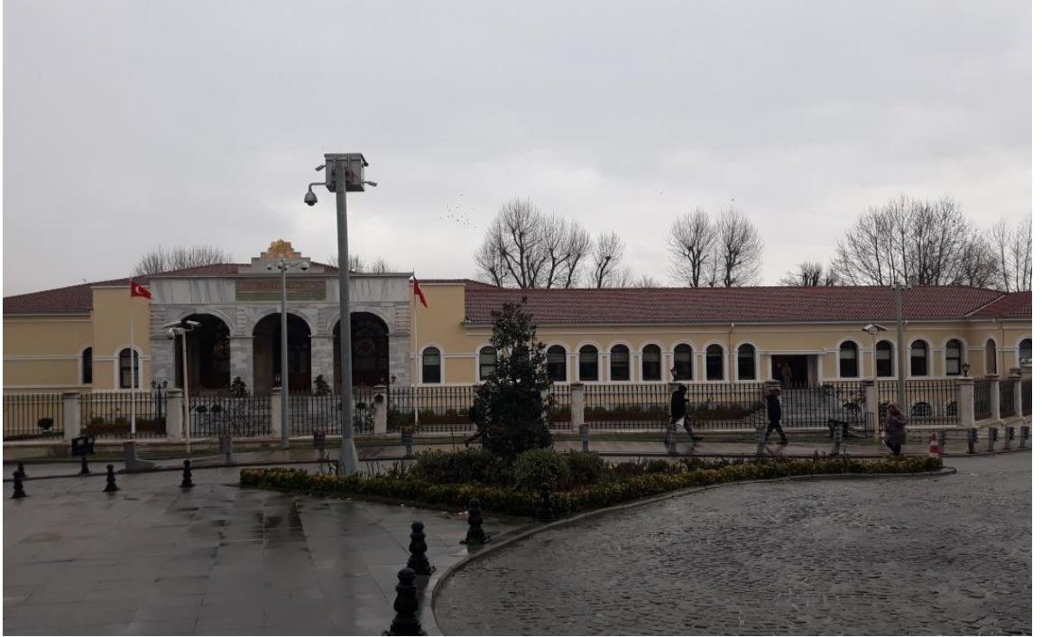
Fotoğraf 7: İstanbul Valilik Binası
