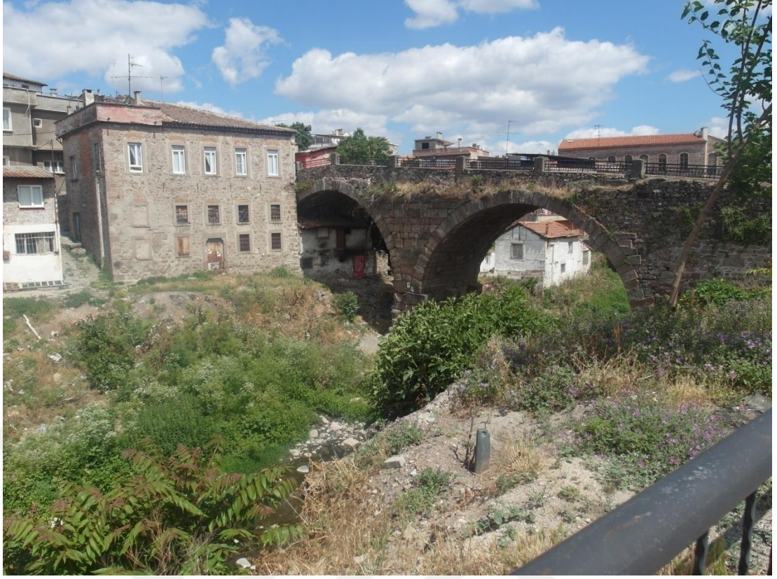
Ek 11: Bergama'nın, Altından Selinos Çayı Geçen Tarihi Köprüsü ve Seyahatnamelerde Bahsedilen "Ne Yerde Ne Gökte Mahallesi"
