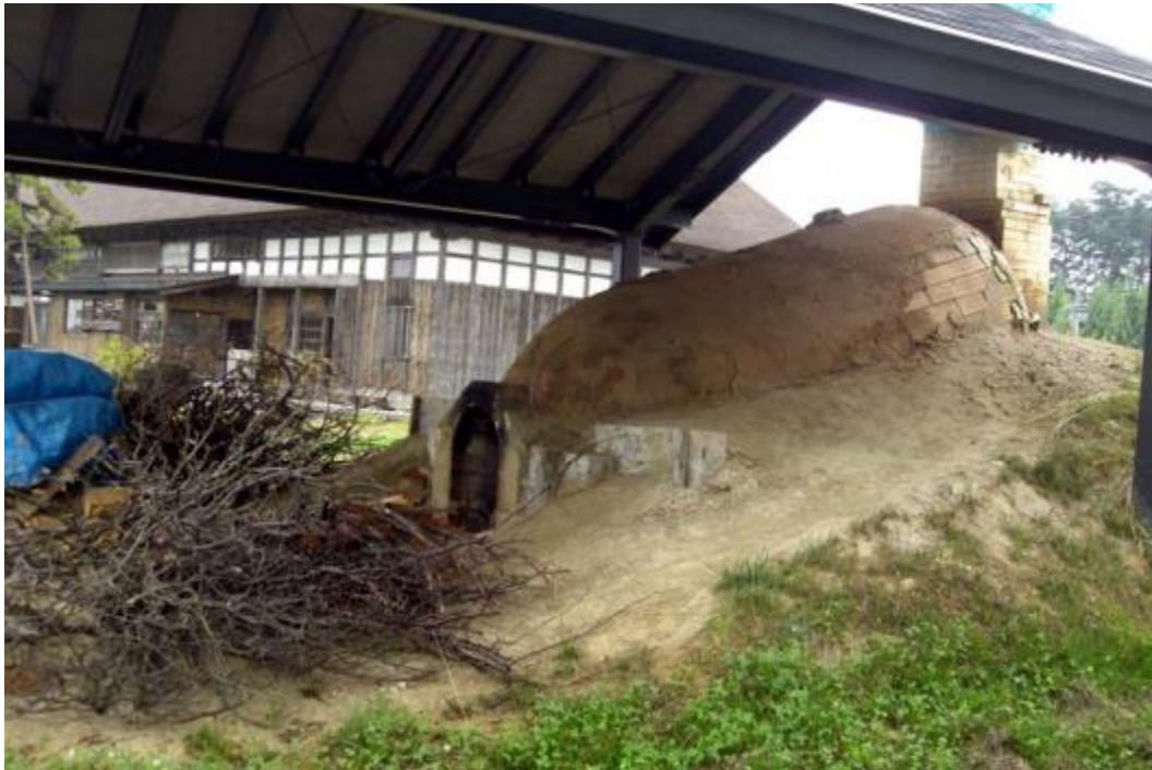
Resim-14: Sueki Tipi Fırın, Kanayama Fabrikası, Amori, Japonya, Fotoğraf: Sevim Çizer
