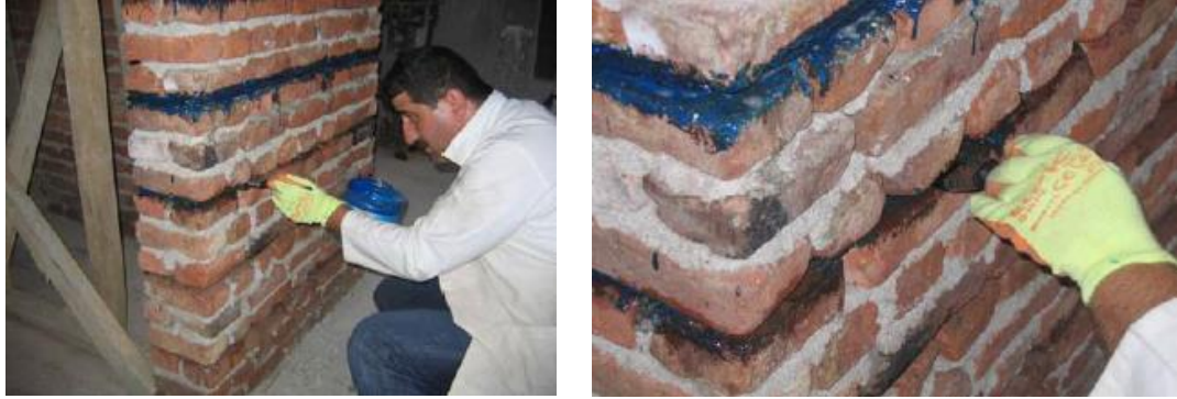
Şekil 52. Reçinenin uygulama yapılacak yüzeye uygulanışı (Çöğürçü, 2007, s.118).
