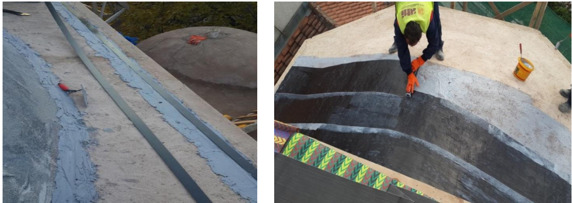
Şekil 59. Tarihi yapılarda şerit ve kumaş KFTP güçlendirme örnekleri (Koç, 2015, s. 5).
