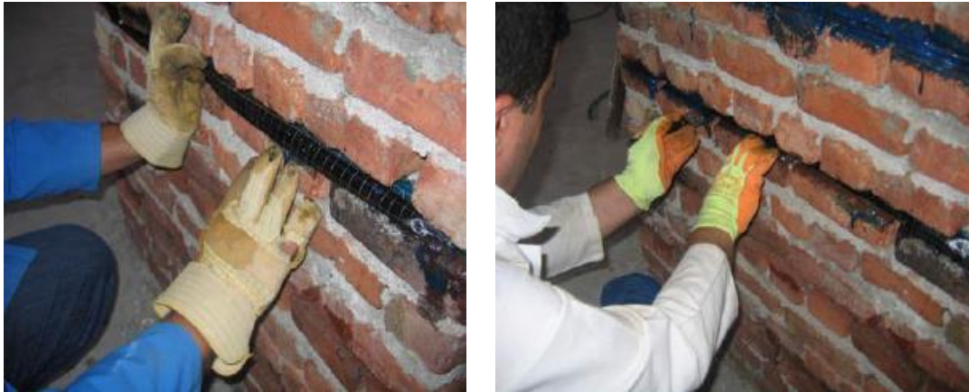
Şekil 54. FTP' nin duvara uygulanışı (Çöğürçü, 2007, s. 119).
