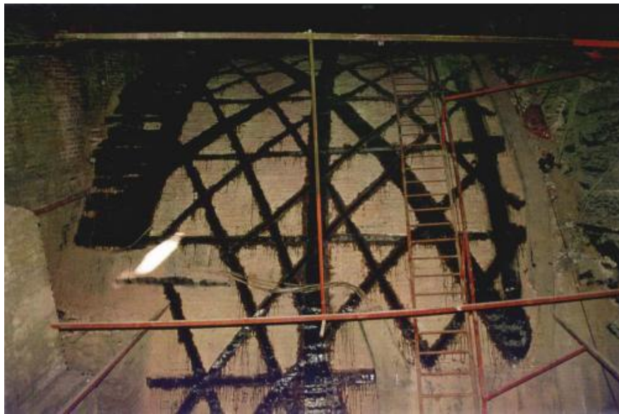
Şekil 57. FTP' nin kemerlere uygulaması (Onar, 2007, s. 28).
