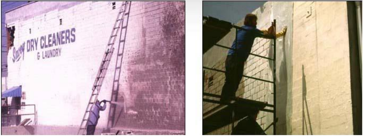
Şekil 55. FTP' nin yığma duvara uygulaması ( URL-4; Akt., Onar, 2007, s. 27).
