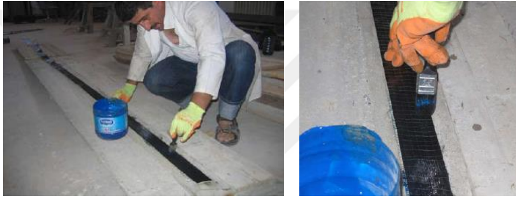
Şekil 53. Reçinenin FTP üzerine uygulanışı (Çöğürçü, 2007, s. 118).
