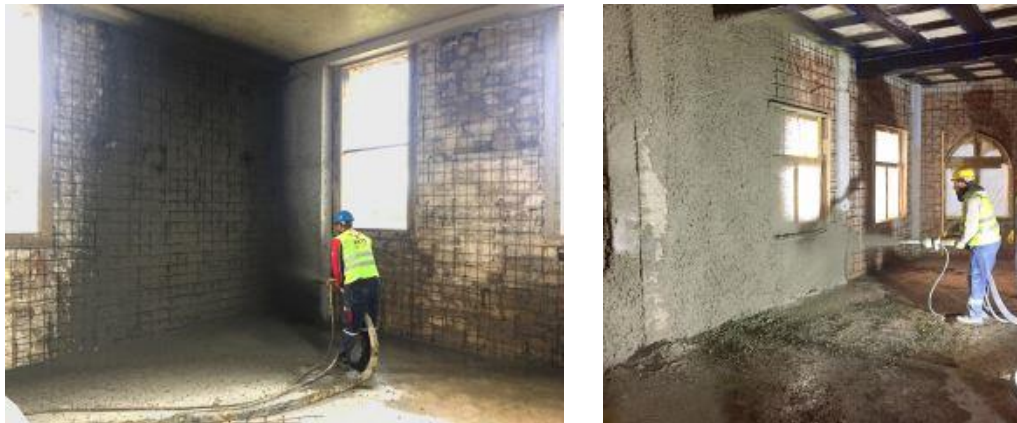
Şekil 47. Yığma duvarların püskürtme beton ile güçlendirilmesi uygulamaları (URL-2).
