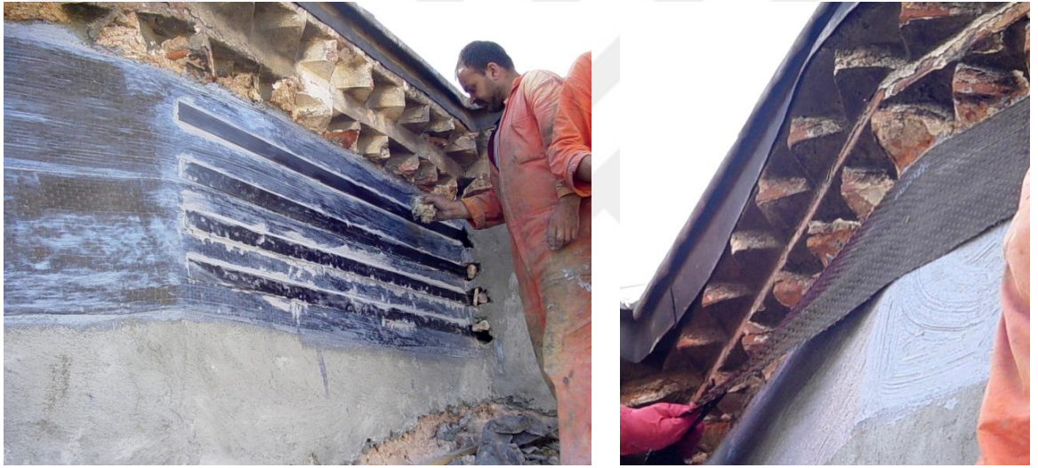
Şekil 56. FTP' nin kubbe kasağına uygulaması (Güler vd., 2004; Akt., Aköz, 2008, s. 39).
