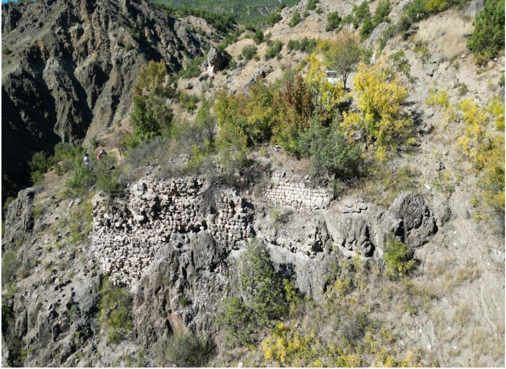
Şekil 19. Cevizli bağlar gözetleme kulesi dronla güneydoğu yönünden görünümü (Cevizli köyü) (Kaynak: Köse, 2025).
