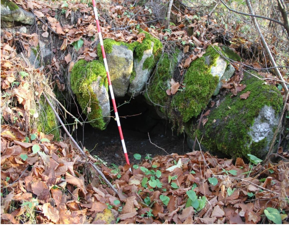
Şekil 10. Yerleşim alanı sığınak (depo) giriş
