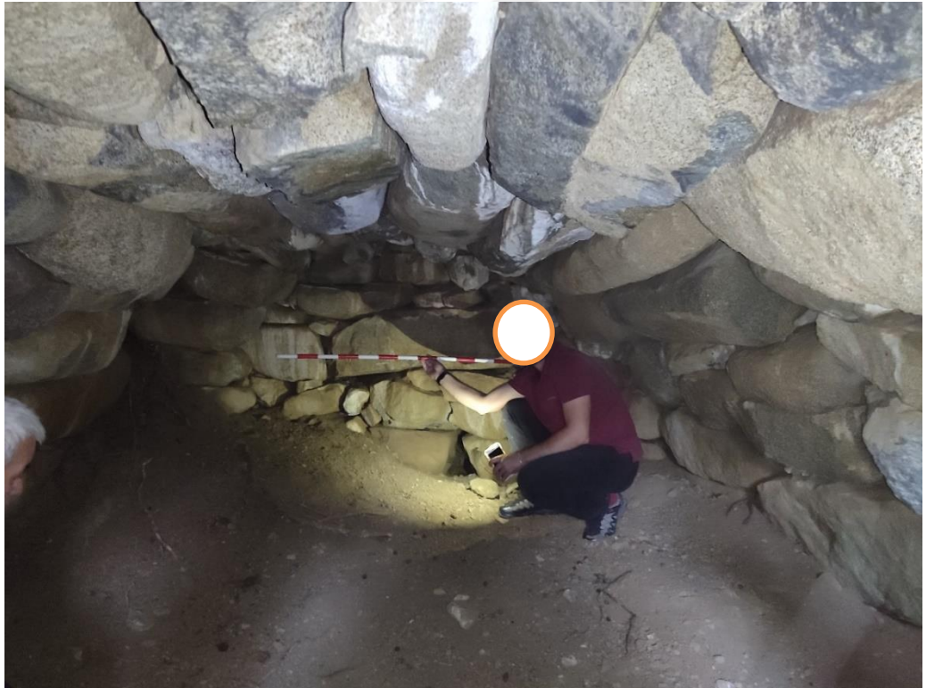
Şekil 15. Depo sığınak iç görünümü
