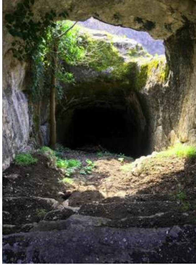
Resim 7: Kevgir Kalesi Basamaklı Tüneli Girişi (Bulut, 2017, s. 205).
