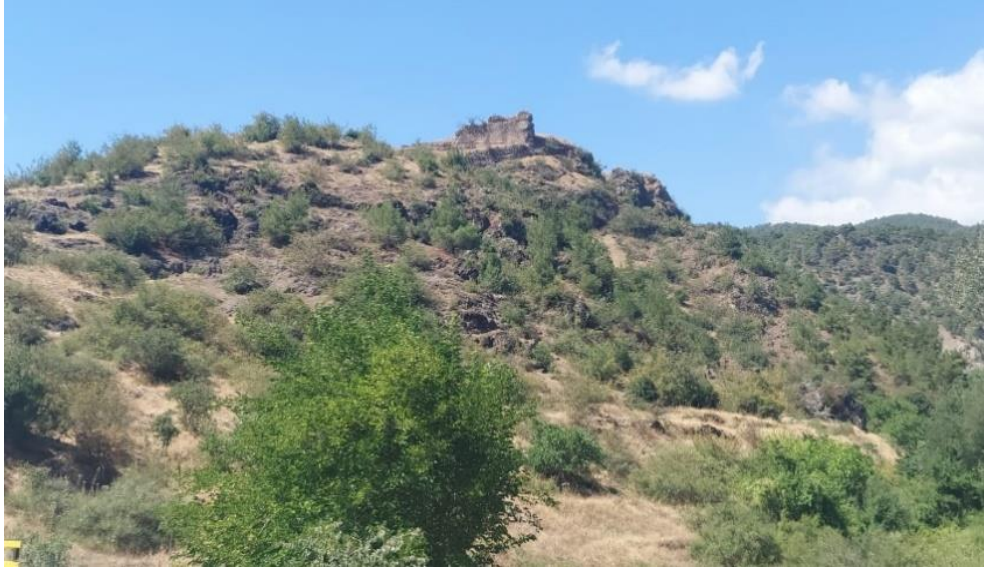
Resim 2: Boğazkesen/ Kaleköy Kalesi Genel Görünüm
