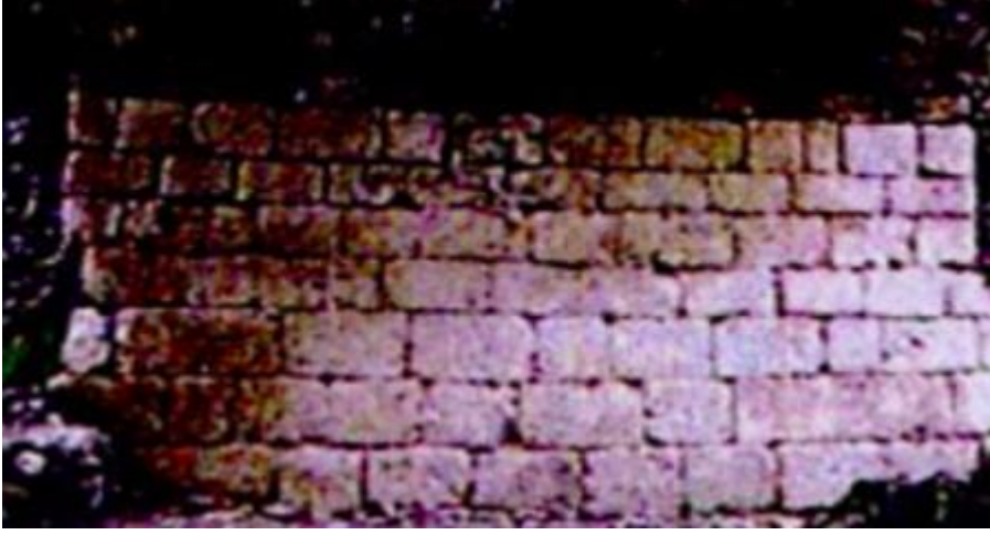
Resim 50: Gölceğiz Köprüsü Kesme Taş Duvar Örgüsü (SKTVKBK, D.K.V.K.E).
