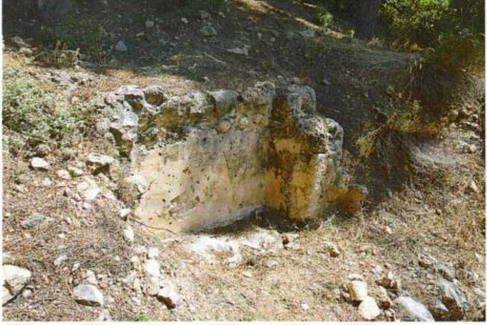
Resim 33: Kösere Mevkisi Yerleşimi Horasan Harçlı duvar Kalıntısı (SKTVKKBK, D.K.V.K.E).
