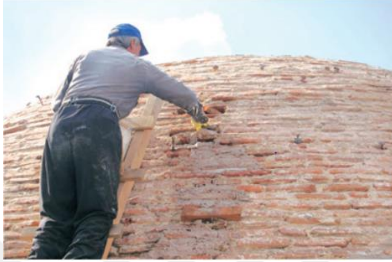
Şekil 1.38. Filibe Cuma Camisi kubbe çatlakların dikiş yöntemiyle onarılması (Küçük, 2010).
