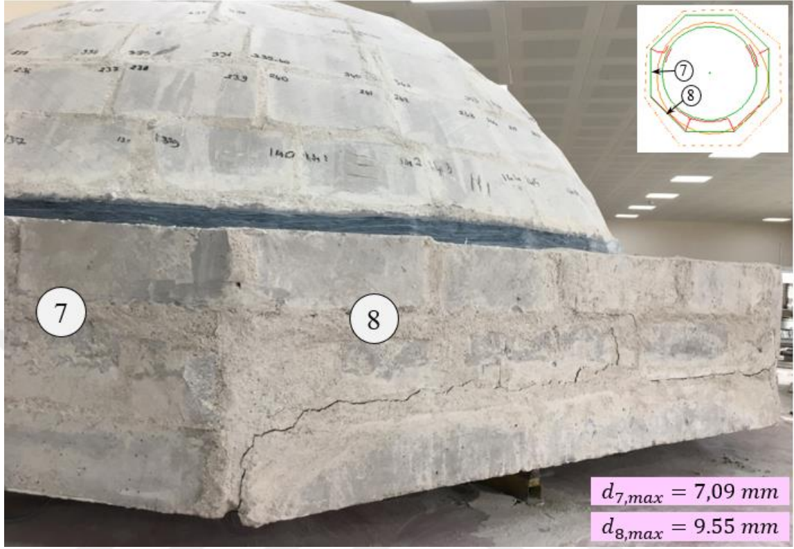
Şekil 4.44. EPS numunesinde oluşan çatlaklar; 7-8 kollar arası çatlaklar.
