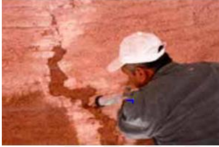
Şekil 1.32. Kubbe çatlaklarının enjeksiyon yöntemiyle doldurulması (Ceylan ve Ocakcan, 2013).
