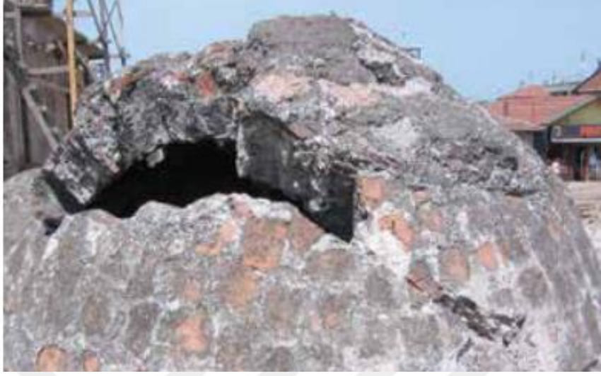
Şekil 1.31. Küçük kubbelerde meydana gelen kısmi çökmeler (BASF, 2018).
