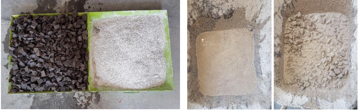
Şekil 3.20. Kubbe kasnağındaki dolgu malzemeleri.
