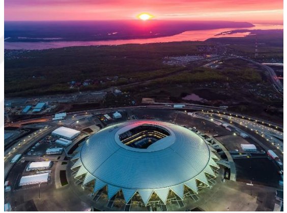
d) Samara Arenası (URL-39)
