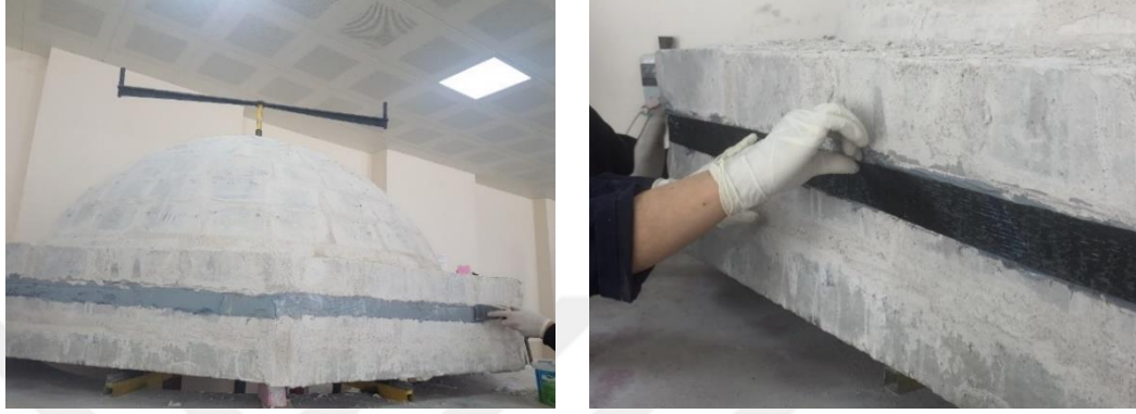
Şekil 3.33. Kubbede FRP bant uygulaması.
