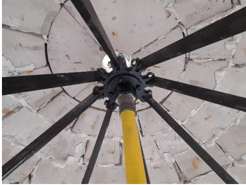
Şekil 3.15. Çelik halka ve sekiz tane çelik çubuk.
