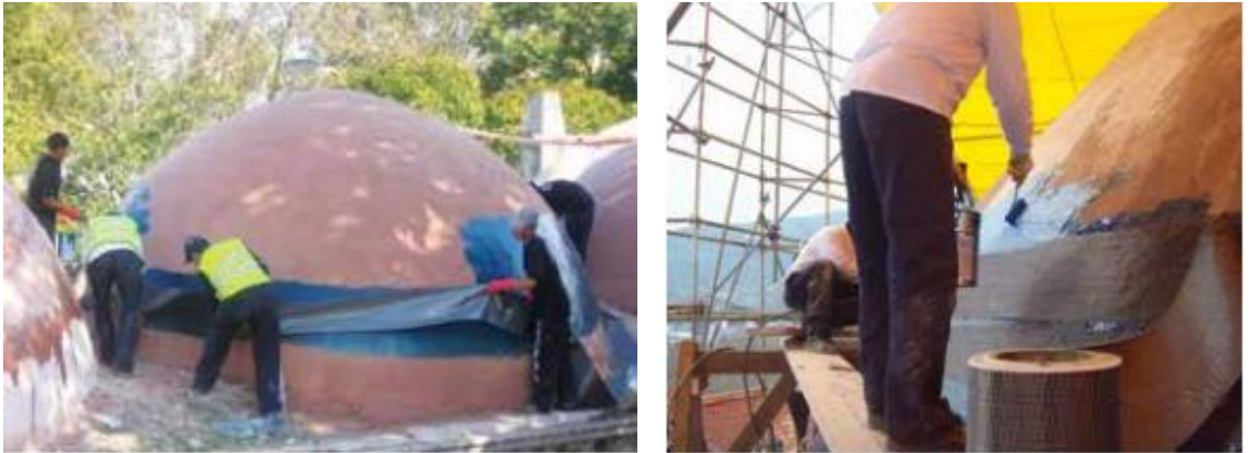
Şekil 1.41. Lif Takviyeli Polimer (FRP) kullanılarak kubbelerin güçlendirilmesi (BASF, 2018).
