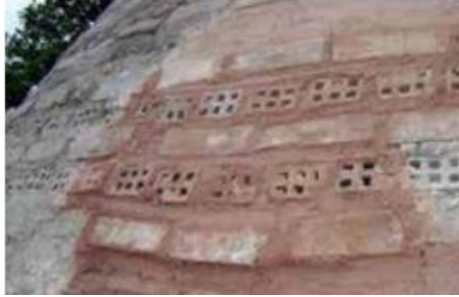
Şekil 1.33. Kubbenin dıştan harç ile onarılması (Çılı ve Yıldız, 2013).
