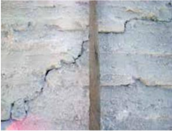
Şekil 1.36. Kubbe hasarı ve dikiş yöntemi uygulaması (Çılı ve Yıldız, 2013).
