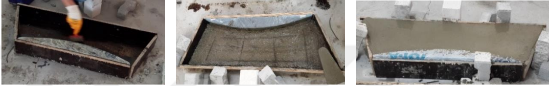
Şekil 3.11. Beton kasnağı için beton dökümü.
