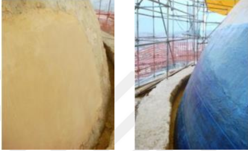
Şekil 1.42. Üskü� Mustafa Paşa Cami kubbesinin FRP ile onarılıp güçlendirilmesi (Karakuş, 2019).
