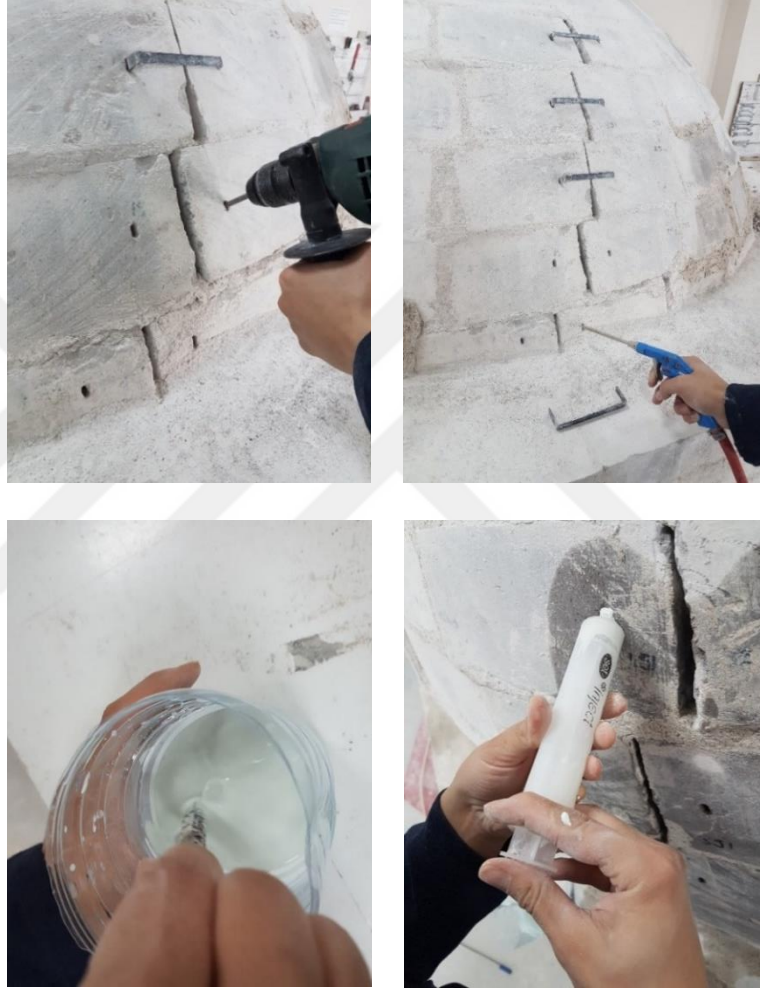
řekil 3.27. Kubbe tařının delinmesi ve tamir harcının doldurulması.
