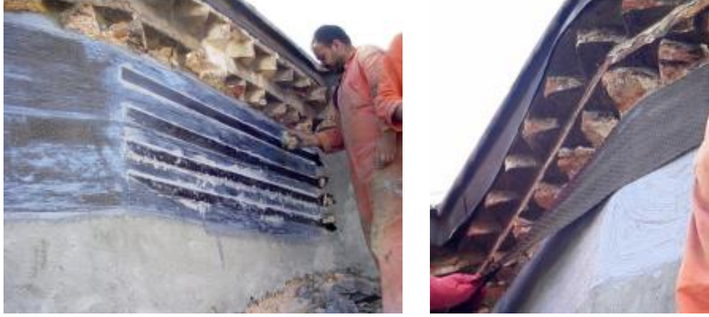
Şekil 1.44. Küçük Ayasofya Cami Kubbe kasnağında FRP uygulaması (Aköz, 2008).
