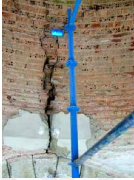
Şekil 1.34. Kubbede geniş çatlakların restorasyon uygulaması (Ceylan ve Ocakcan, 2013).
