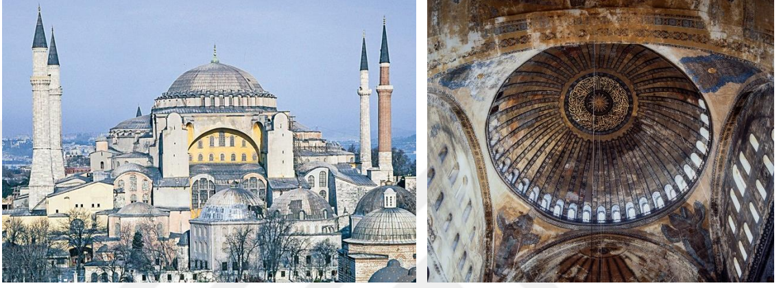
Şekil 1.4. Ayasofya Camii ve kubbesi (URL-3).
