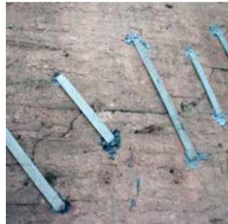
Şekil 1.36. Kubbe hasarı ve dikiş yöntemi uygulaması (Çılı ve Yıldız, 2013).
