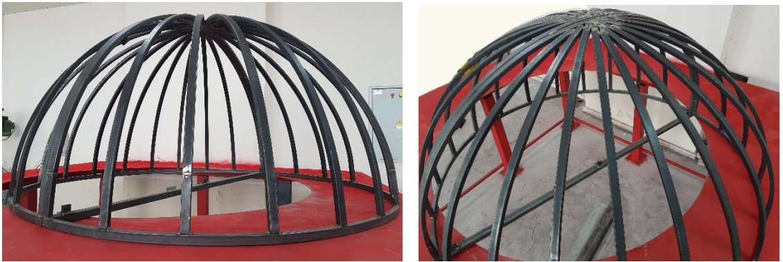
Şekil 3.2. Kubbe kalıbı.
