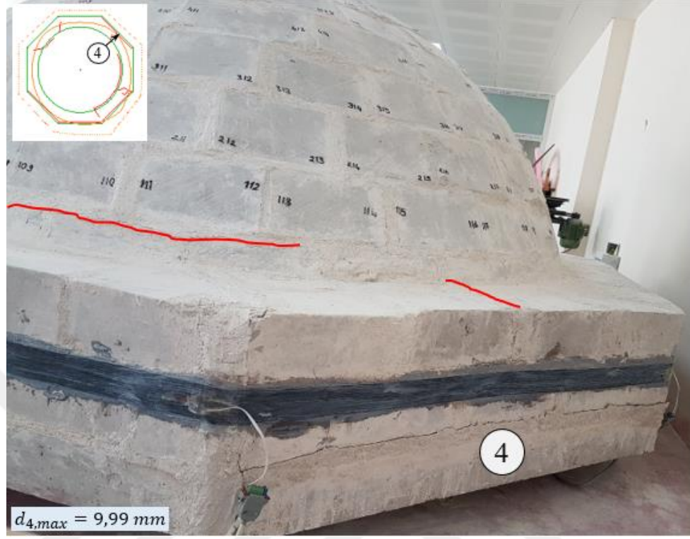
Şekil 4.58. EPD numunesinin 4. kol üzerinde oluşan çatlaklar.
