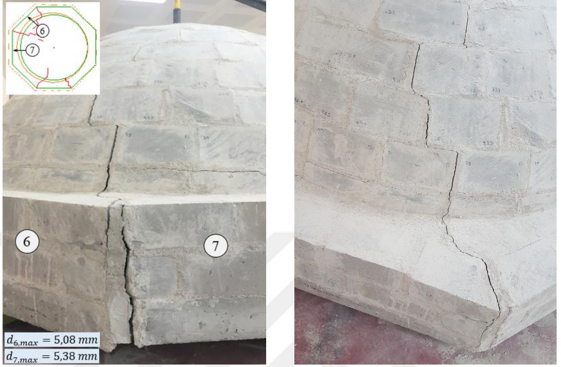
Şekil 4.4. ERef numunesinde 6. ve 7. kolları arasında oluşan çatlak.
