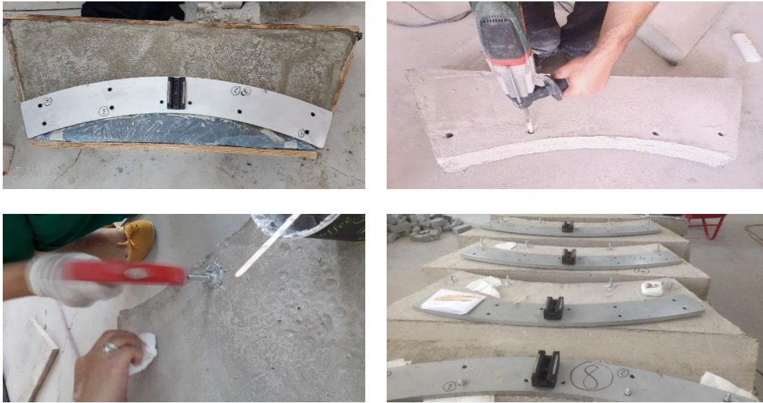
Şekil 3.12. Beton kasnağını altına çelik kasnak profilinin yerleştirilmesi.
