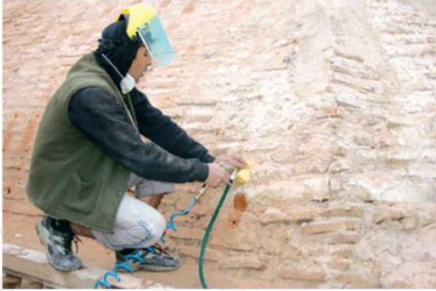
Şekil 1.35. Kubbe çatlaklarının enjeksiyon yöntemiyle doldurulması (Küçük, 2010).
