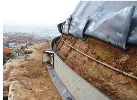
Şekil 1.39. Kubbe hasarı ve çekme çemberi uygulaması (Sesigür ve Çılı, 2014).
