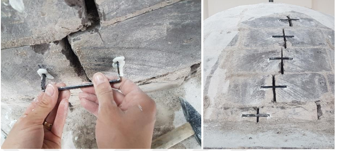
Şekil 3.28. Dikiş yönteminin uygulanması.
