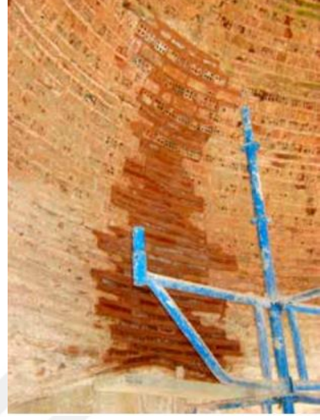
Şekil 1.34. Kubbede geniş çatlakların restorasyon uygulaması (Ceylan ve Ocakcan, 2013).
