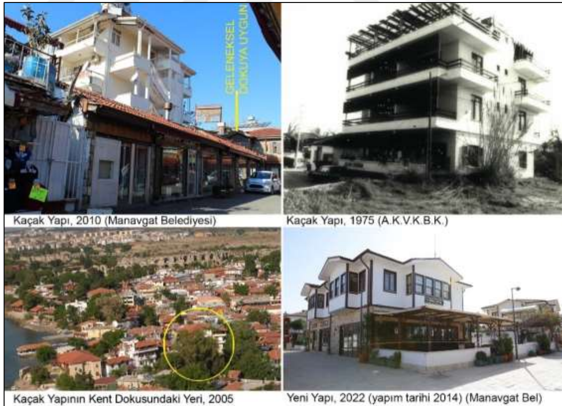
Şekil 4.108: Yıkım öncesinden günümüze 453 parsel (Yazar tarafından hazırlanmıştır)
