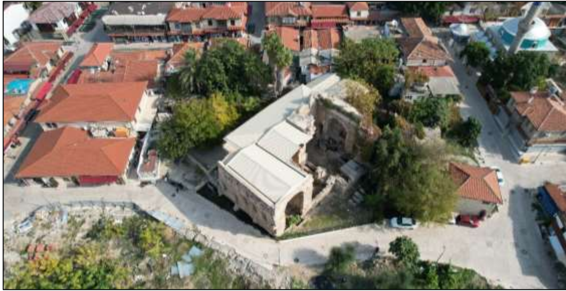
Şekil 4.16. Liman Hamamı (S), (Manavgat Belediyesi arşivi 2022)
