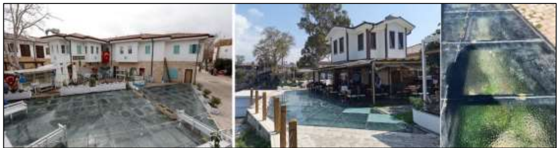
Şekil 4.121. Hava sirkülasyonunun sağlanmaması sebebiyle cam döşemelerde nemlenme ve kalıntılarda bitkilenme, kırılan cam döşemeler (Bunlar arkeolojik kalıntılara fiziksel zarar verirken, ziyaretçiler için de izlenebilir olmalarını engellemektedir.) (Yazar tarafından hazırlanmıştır)
