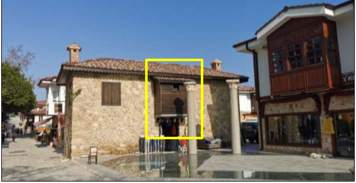
Şekil 4.84. 471 Parseldeki Tescilli yapının restorasyon sonrası cumbasında yapılan wc penceresi (Yazar arşivi 2023)
