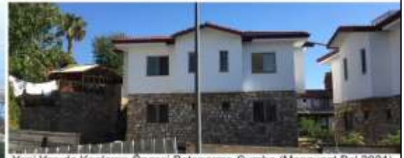
Yeni Yapıda Kaplama Öncesi Betonarme Cumba (Manavgat Bel.2021)
