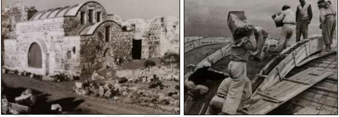
Şekil 4.46.a; b) Restore edilen Agora Hamamı ve tonoz betonu dökülürken, 1961 (Yılmaz 2017)
