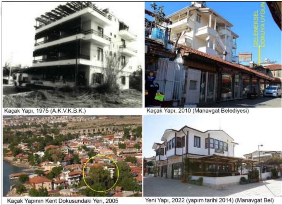
Şekil 4.52. 453 Parseldeki yapı, Side'nin en eski kaçak yapılan pansiyon yapılarından (3 katlı olan yapı zamanla çatı katı da büyütülmüş) (Yazar tarafından düzenlenmiştir)
