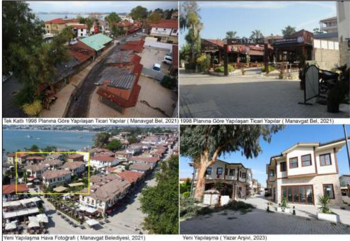
Şekil 4.77. 2014 Planına göre yapılaştıran Ayrık Nizam yapılaşma örneği, 454 parsel (Yazar tarafından düzenlenmiştir)
