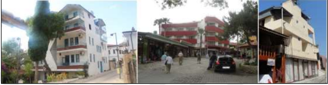
Şekil 4.65. Çok katlı yoğun yapılaşma örnekleri (Manavgat Belediyesi arşivi 2010)
