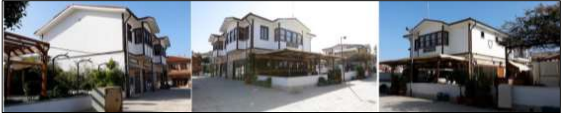
Şekil 4.117. İlk yıkılıp, ilk Yapılaşan 453 parseldeki yeni yapı (Ön bahçesi bulunmayan yapı Bitişik Nizam düzeninde yapılmıştır. Kütle, Gabari olarak 2014 yılı plan hükümlerine uygundur. Kapalı çıkmaları (cumbaları), açık çıkmaları ve cephe elemanlarıyla kullanılan malzeme doğrultusunda plan hükümlerine uygun yapılmıştır.) (Manavgat Belediyesi 2021) (Yazar tarafından hazırlanmıştır.)
