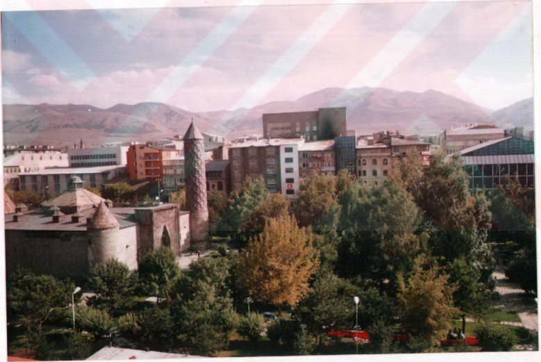
Şekil 4.10. Yakutiye Medresesi park alanında yapılmış yoğun bitkilendirmeden bir görünüm
