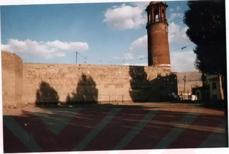
Şekil 4.12. Erzurum Kalesi Saat Kulesinden bir görünüm
