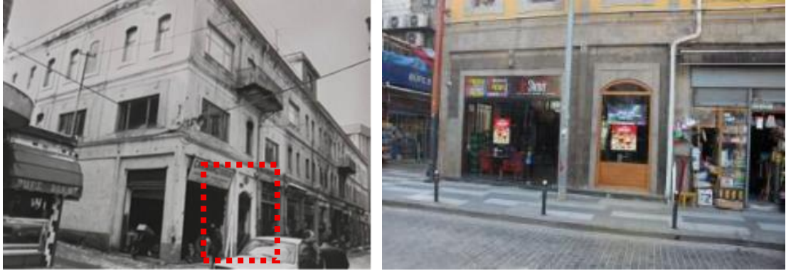
Şekil 66. Kuzey cephesinde yer alan 1971 yılındaki özgün kapı girişi ve günümüze ulaşamayan giriş bölümü (Zan Mimarlık, 2023; M. Türkköylü fotoğraf arşivi, 2023)
