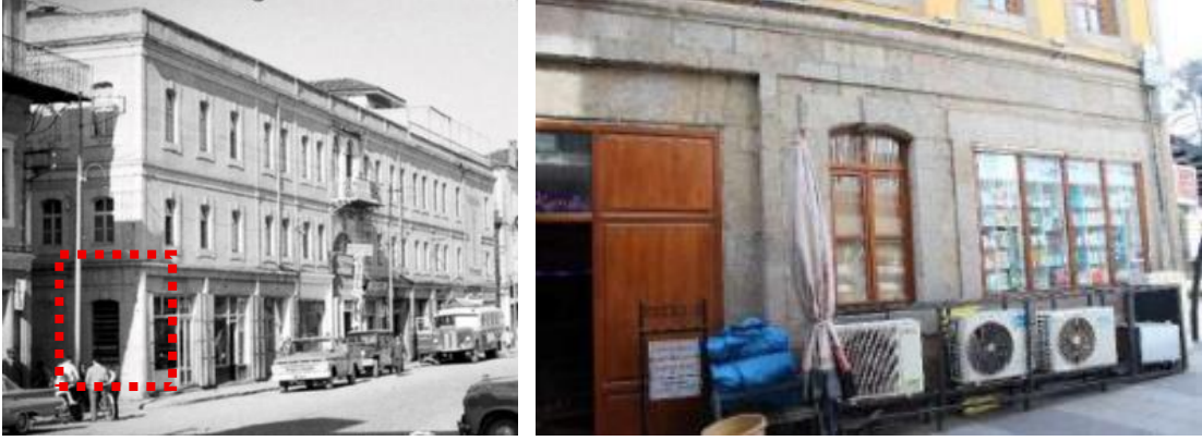
Şekil 64. Batı cephesi zemin kat seviyesinde tahrip edilen pencere bölümü ve günümüzdeki camekan düzenlemesi (M. R. Sümerkan fotoğraf arşivi, 1950; M. Türkköylü fotoğraf arşivi, 2023)
