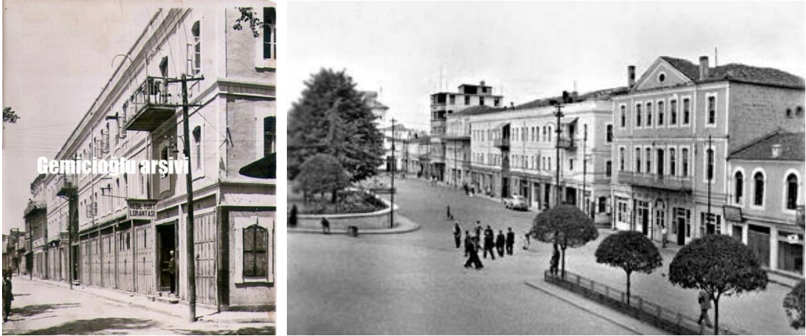
Şekil 70. Eski Yeşilyurt oteli güney cephesi özgün balkon ve çatı düzeni (Gemicioğlu fotoğraf arşivi, M.R. Sümerkan fotoğraf arşivi, 1950)
