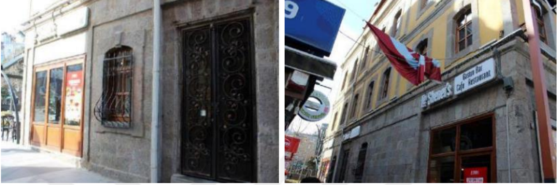
Şekil 61. Doğu cephesi zemin kat seviyesi (M. Türkköylü fotoğraf arşivi, 2023)
