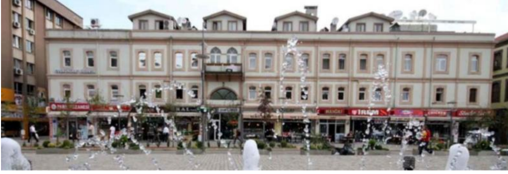
Şekil 73. Güney cephesi 1980-1990 yılları arası görünüşü (M.R. Sümerkan fotoğraf arşivi)
