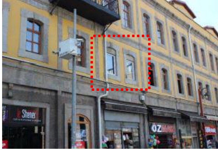
Şekil 67. Kuzey cephesinde birinci kat seviyesinde tahrip edilen pencere bölümü (M. Türkköylü fotoğraf arşivi, 2023)
