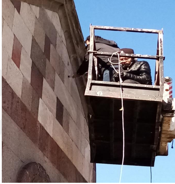
Şekil 4.2. Emir Saltuk Kümbeti dış duvarlarına Schmidt çekici uygulaması
