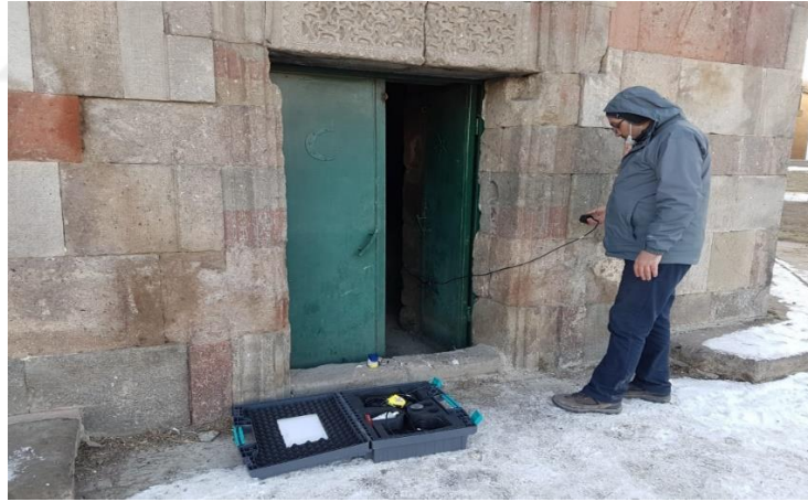
Şekil 3.21. Emir Saltuk Kümbeti duvarlarına ultrases geçiş hızı tayini uygulaması
