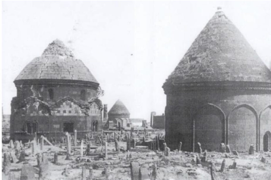
Şekil 3.7. Üç Kümbetler bölgesi restorasyon öncesi görünümü (Özkan 2016)
