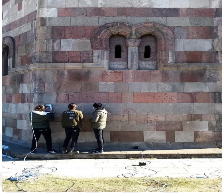
Şekil 4.14. Emir Saltuk Kümbeti duvarlarına Schmidt uygulaması
