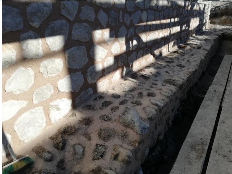
Şekil 3. 13. Hamam çevre duvarı capping uygulaması sonrası
