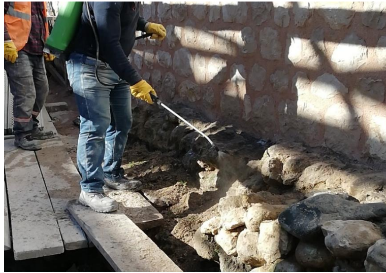
Şekil 3. 20. Basınçlı su ile malzeme temizliği
