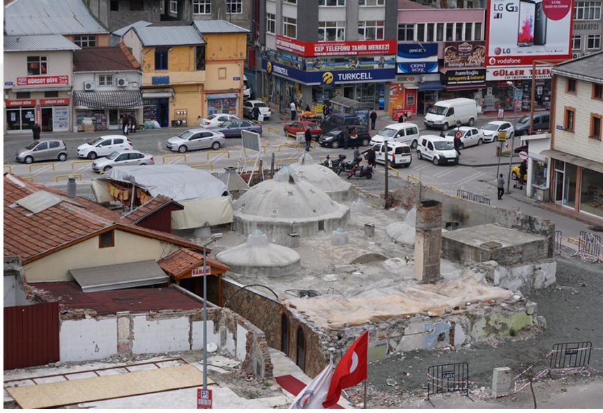
Şekil 3. 2. Hamam beden duvarlarında kalan malzeme artıkları (VGM arşivi)
