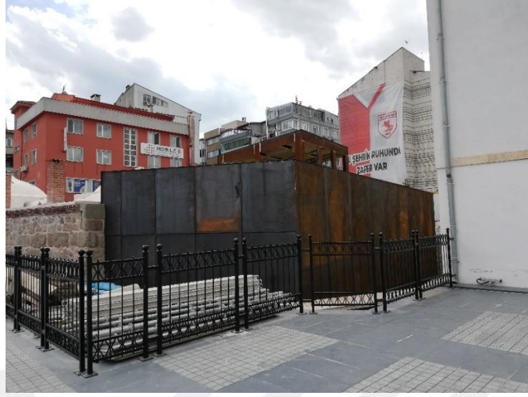
Şekil 3. 24. Çağdaş soğukluk bölümünün COR-TEN® çeliği ile kaplanması
