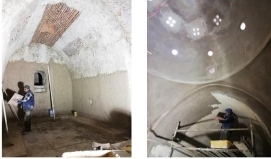
Şekil 3. 21. Tonoz ve kubbe örtülerine sıva uygulaması işlemleri
