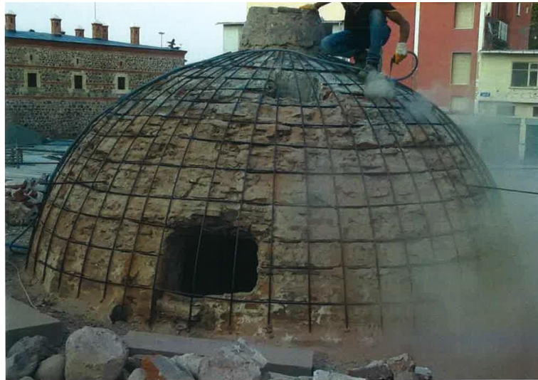
Şekil 3. 18. Ana kubbe çatı örtüsünün FRP çubukları ile güçlendirilmesi
