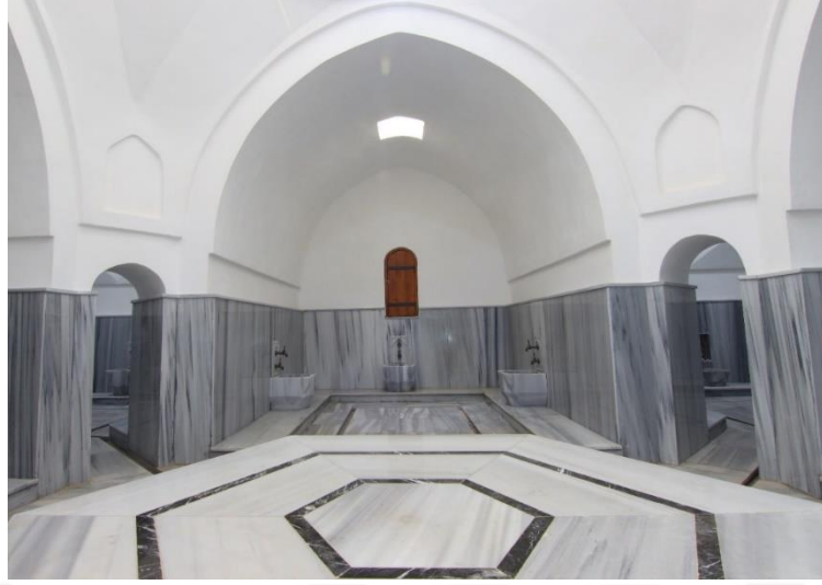
Şekil 2. 14. Şifa Hamamı sıcaklık bölümü merkezi, eyvan, halvet girişleri ve su deposuna geçiş penceresi, güneybatı yönü
