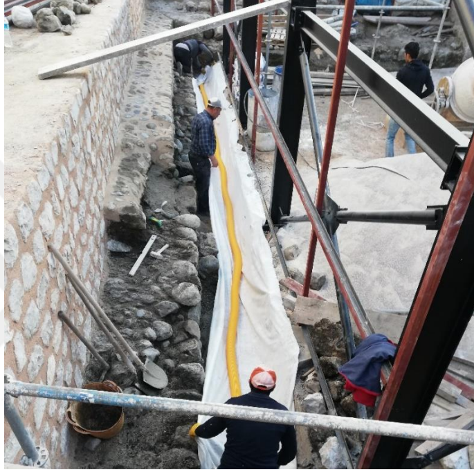
Şekil 3. 9. Hamam çevresine uygulanan drenaj sistemi imalatı
