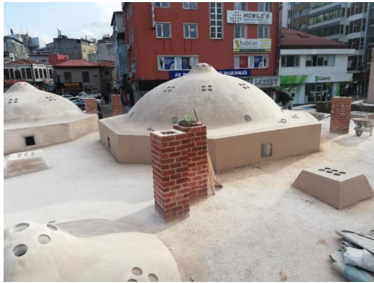
Şekil 3. 22. Çatı örtüsünün sıva uygulandıktan sonraki genel görünüşü
