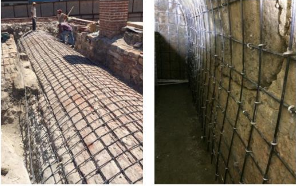
Şekil 3. 15. Su deposu tonoz çatı örtüsünün güçlendirmesi dış ve iç cepheler görünüş
