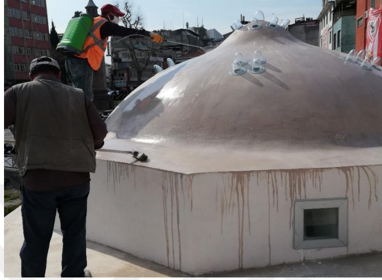
Şekil 3. 19. Çatı örtüsüne su itici sürülmesi
