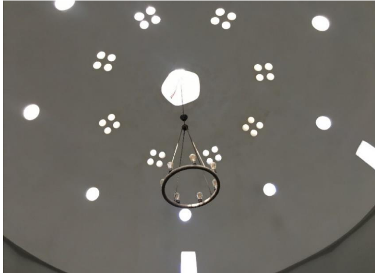
Şekil 3. 11. Hamamın ana kubbesinde bulunan ışıklıklar
