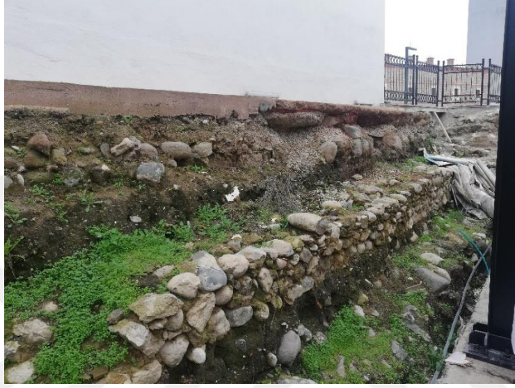
Şekil 3. 12. Hamam çevre duvarı capping uygulaması öncesi
