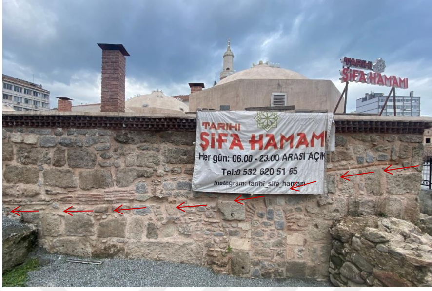
Şekil 3. 35. Şifa Hamamı güneydoğu cephe yatay doğrultu ekseninde künk boru
