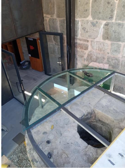
Şekil 3. 28. Kuyu kapağı temperli cam uygulaması
