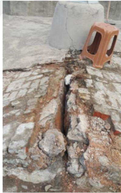
Şekil 3. 5. Tonzda oluşan yapısal çatlağın dış cephe görünümü (VGM arşivi)
