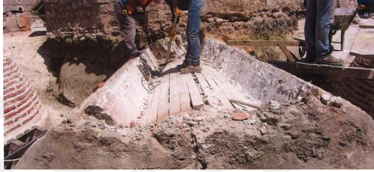
Şekil 3. 17. Tonoz çatı örtüsünün tamamlanması işlemleri
