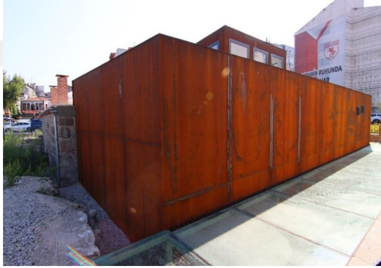
Şekil 3. 25. COR-TEN® çelik kaplanmanın bir süre sonraki görünümü
