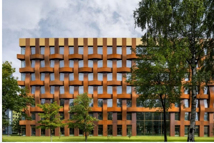
Şekil 2. 22. Ferrum 1 binası cephe görünümü 1 (İlya İvanov)
