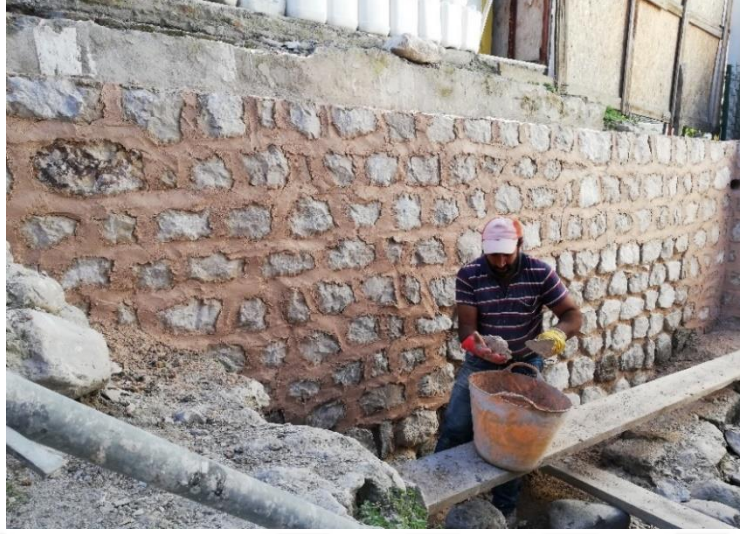
Şekil 3. 10. Hamam duvar örgüsüne uygulanan derzleme işlemi
