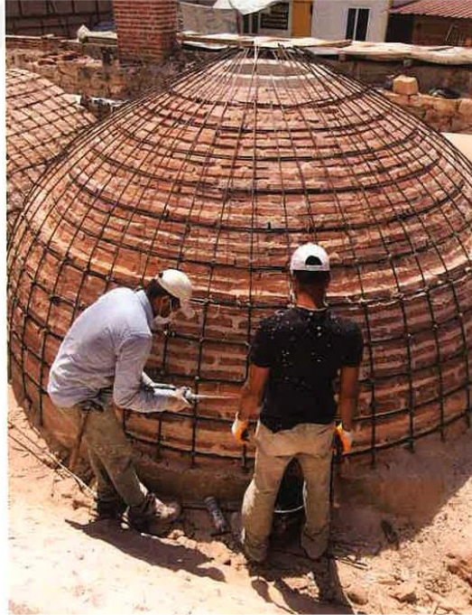
Şekil 3. 16. Kubbe çatı örtüsünün güçlendirmesi
