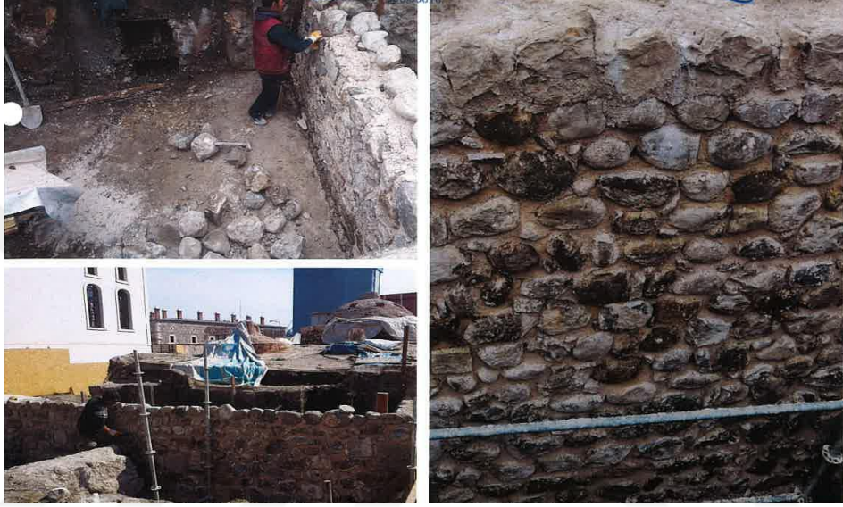
Şekil 3. 14. Külhan duvarının yeniden yapımı
