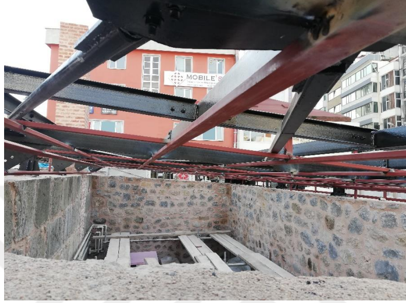
Şekil 3. 26. Tamamlanmış külhan duvarları ve çelik çatı iskeleti
