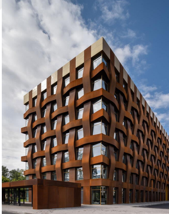
Şekil 2. 23. Ferrum 1 binası cephe görünümü 2 (İlya İvanov)
