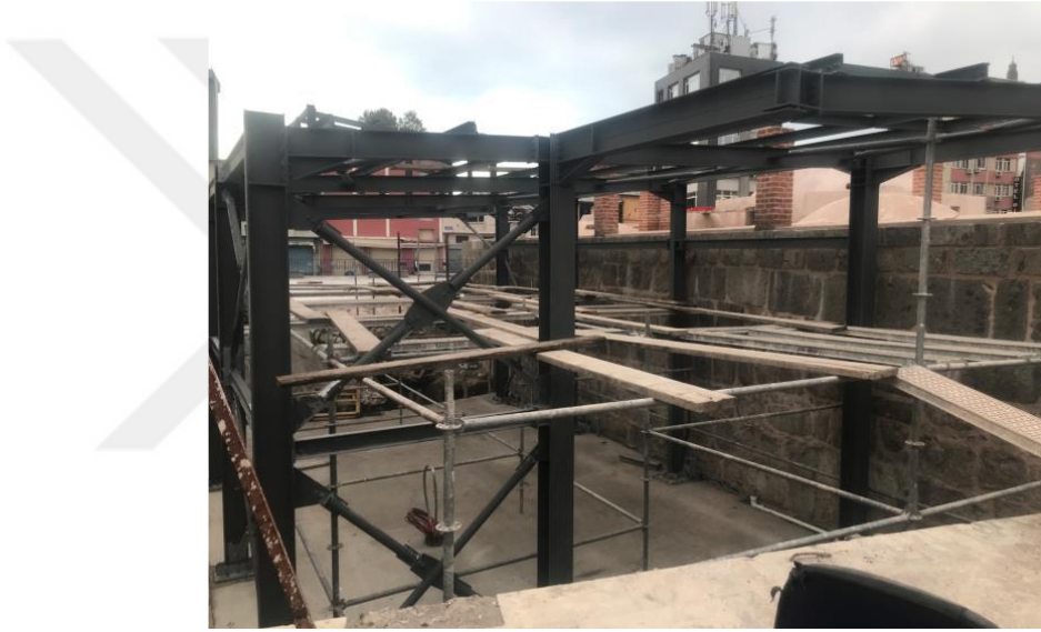
Şekil 3. 23. Çağdaş soğukluk bölümünün çelik iskelet imalatları
