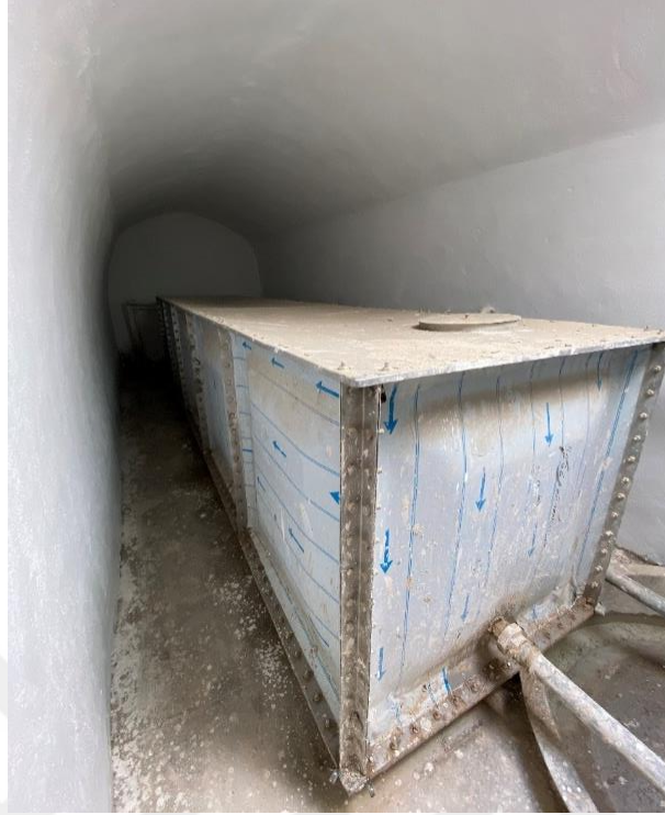
Şekil 2. 16. Şifa Hamamı su deposu bölümü
