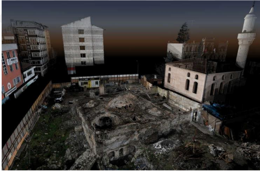
Şekil 3. 1. Yapının restorasyon öncesi durumunun 3D lazer tarayıcı ile görüntülenmesi (VGM arşivi)
