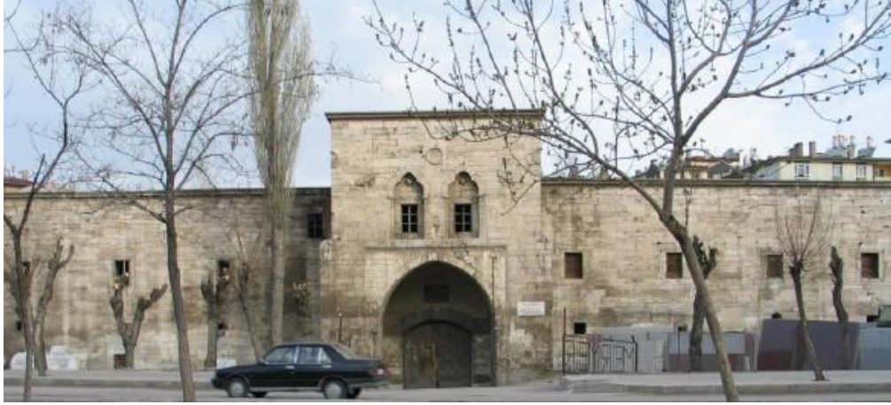
Şekil 3.14. 2016 yılına ait Behram Paşa Hanı'nın Güneydoğu (giriş) cephesi (Arslan, 2016)
