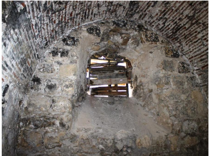
Şekil 3.18. 2016 yılına ait (restorasyon öncesi) hücrelerden revaklara açılan kapı ve pencereler (M.E. DERE ARŞİVİ)
