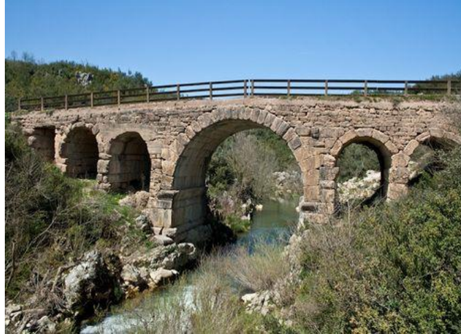
Şekil 1:Roma dönemine ait Kutluca Köprüsü. (URL-1, 2019)
