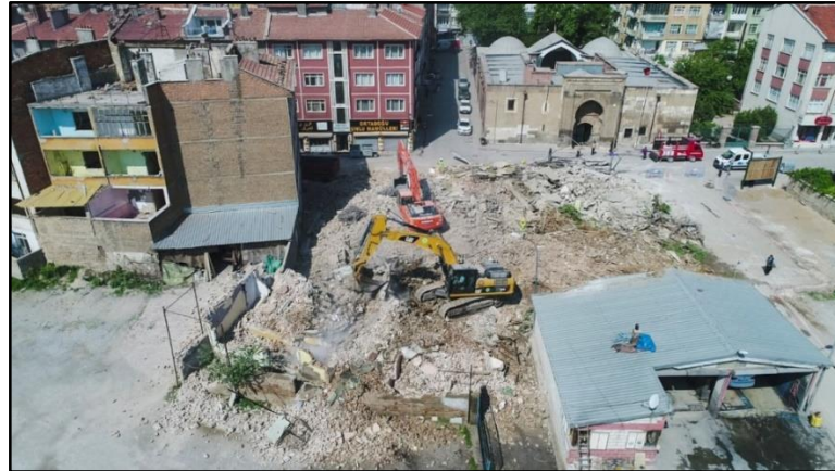
Şekil 5.48. Şükran Mahallesi 2018 yılı Sırçalı Medrese çevresi yıkım ve enkaz temizleme çalışmaları.
