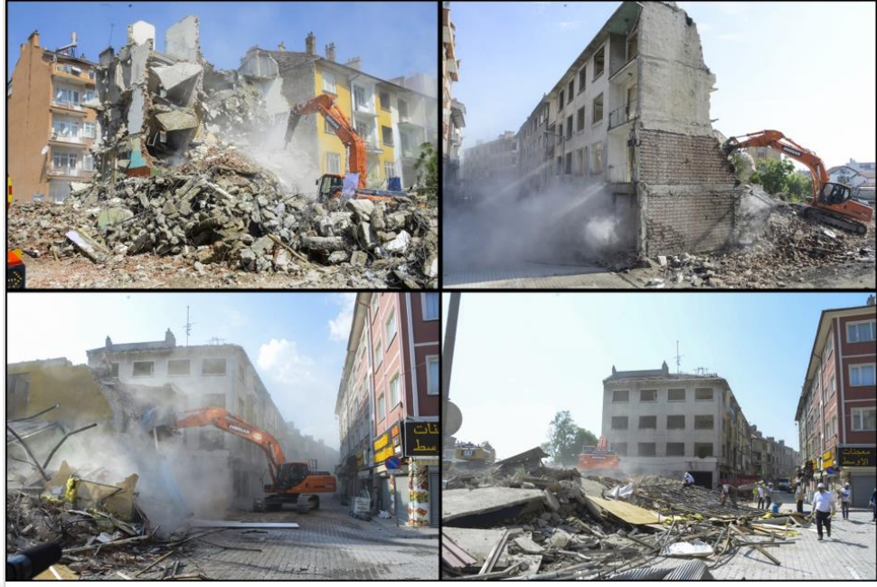
Şekil 5.49. Şükran Mahallesi 2018 yılı yıkım ve enkaz temizleme çalışmaları görüntüleri.
