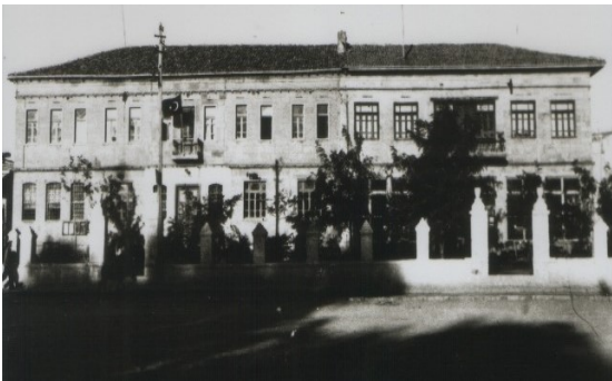
Resim 4.59. Eski Belediye Binası- 1974 yılı öncesi (Gül, 2020)
