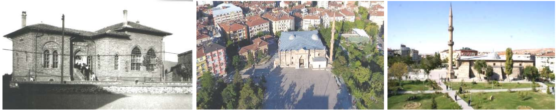
Şekil 11. a. Kütüphane binası 1940-1950 yılı b. Ulu cami ve çevresi (2020) c. Ulu cami güney cephesi ve park (2020)
