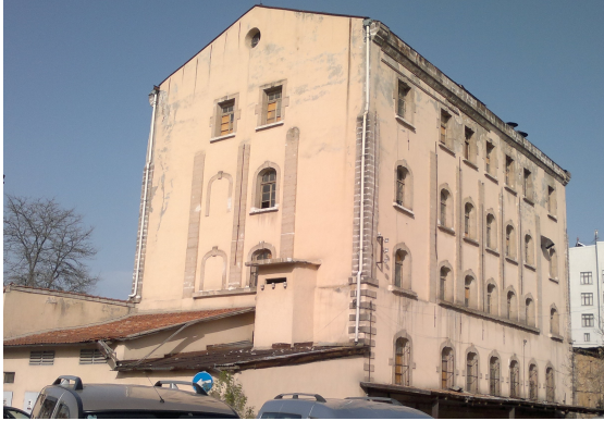
Resim 2.32. Azmi Milli Un Fabrikası Restorasyon öncesi, Aksaray (Özer, 2010)
