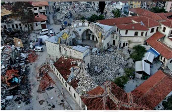
Resim 2. 9. Depremde yıkılan Habib-i Neccar Camii -Antakya (URL-3, 2023)
