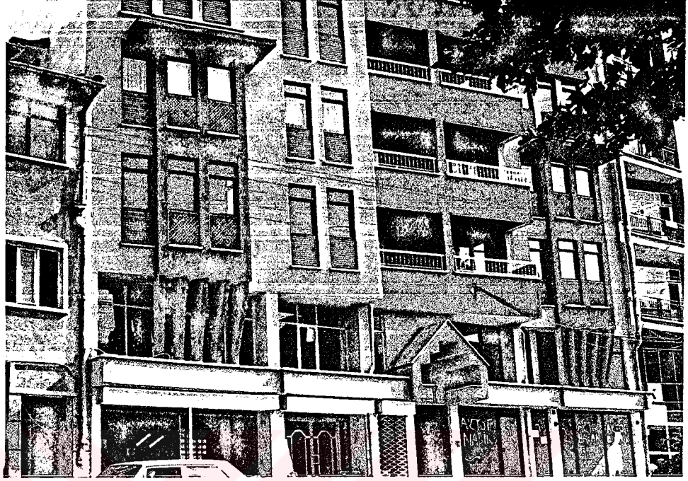
ŞEKİL 5.13 Seyitgazi Caddesinde Yer Alan Koruma Amaçlı İmar Planı Sonrası Yapılan Bir Apartmanın Giriş Cephesinden Detay.
