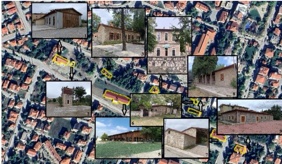
Şekil 4.2 Çivril Tren İstasyonu binalarının restorasyon çalışması sonrası fotoğrafları.
