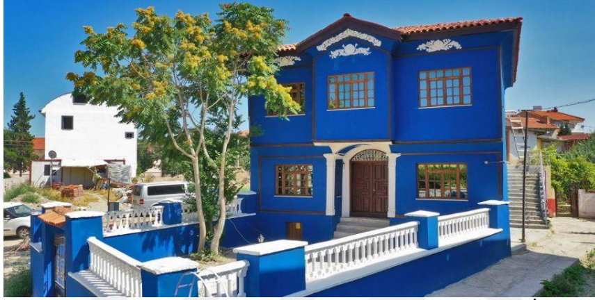
Şekil 4.3 Mavi Konak binasının kuzey cephesinden çekilmiş olan fotoğrafı (İnt.Kyn.27).
