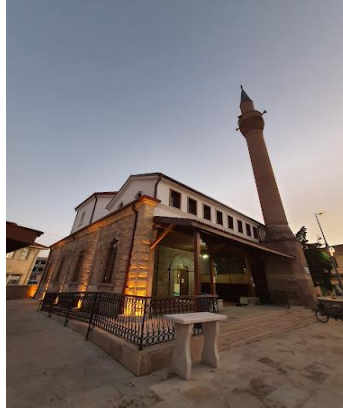
Şekil 4.4 Restorasyonu tamamlanmış olan Çarşı Cami'nin fotoğrafı (İnt.Kyn.29).
