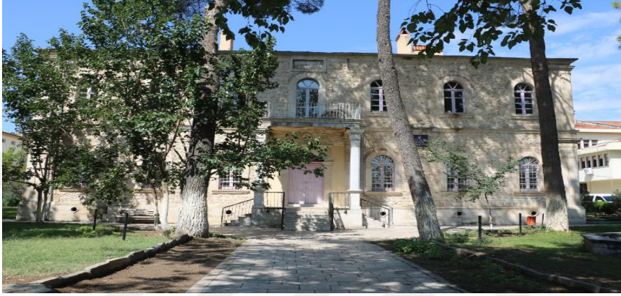
Şekil 4.8 Eski Hükümet Konağı binasının restorasyonu tamamlandıktan sonraki hali (İnt.Kyn.34).
