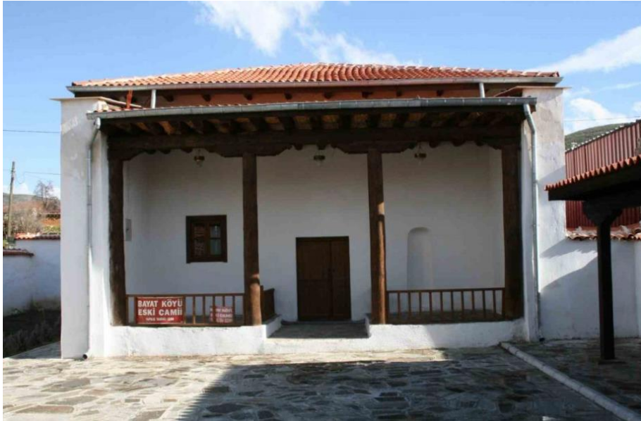
Şekil 4.7 Bayat Camisi'nin restorasyonu tamamlandıktan sonraki görüntüsü (İnt.Kyn.33).
