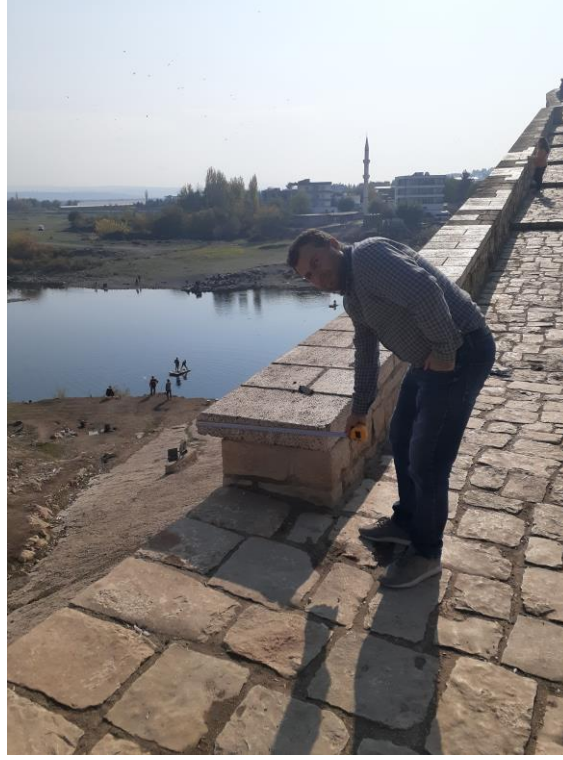
Şekil 2.17. Restore sonrası köprünün harpuşta duvarı
