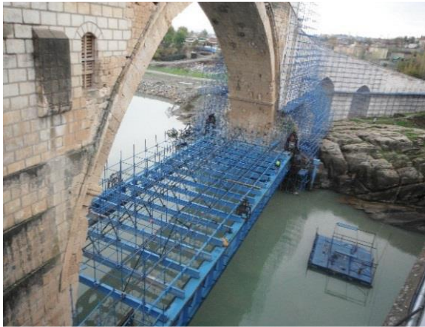
Şekil Ek 2.21. Ana kemer için yapılan iskele sistemi (Halifeoğlu ve ark., 2017)
