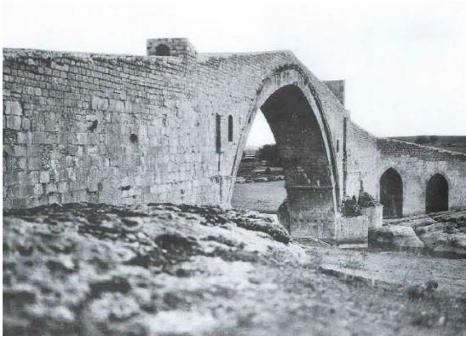
Şekil Ek 2.1. Malabadi Köprüsü memba cephesi (Gabriel, 2014)
