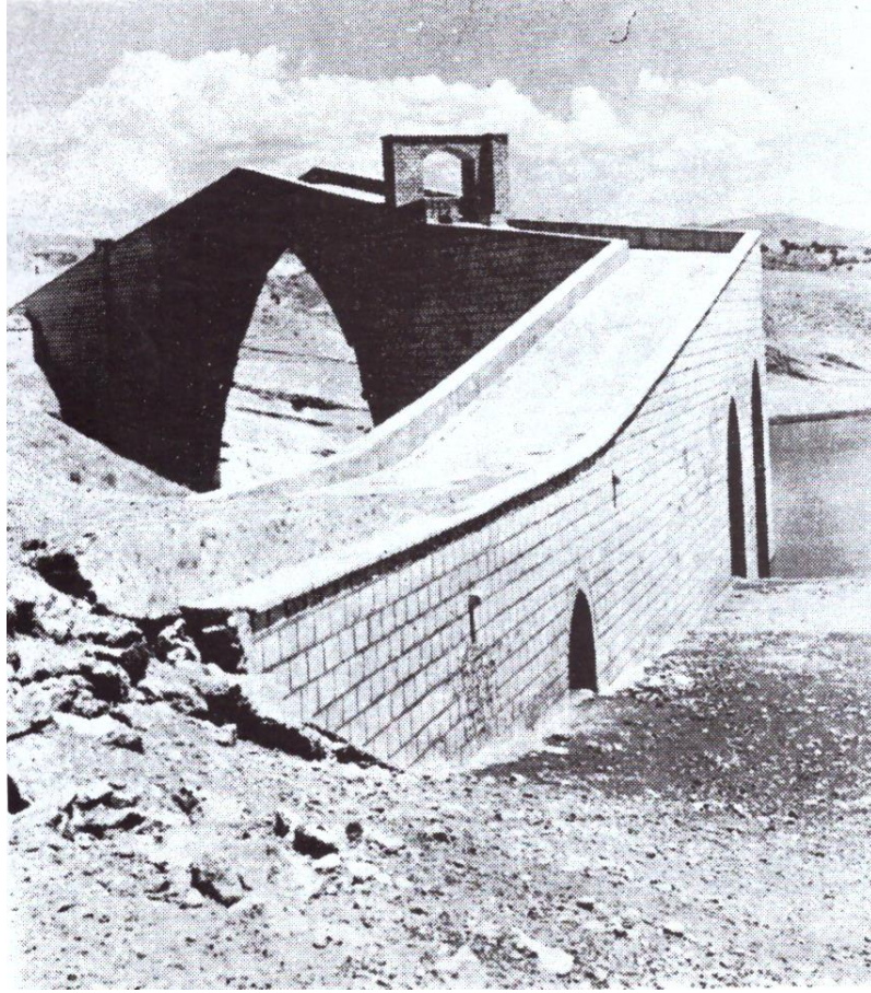
Şekil Ek 2.7. Malabadi Köprüsü memba cephesi (Çulpan, 2002)
