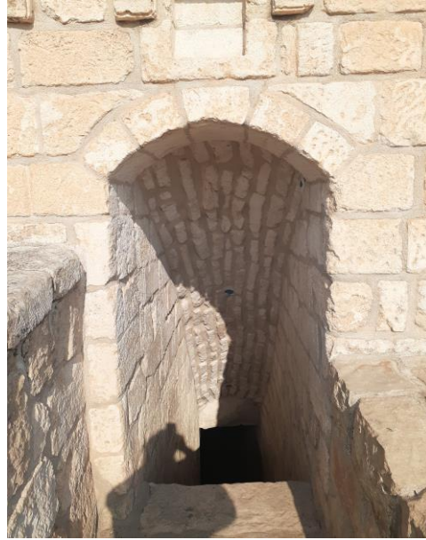
Şekil 2.13. Odacıklara inişi sağlayan merdiven örtüsü
