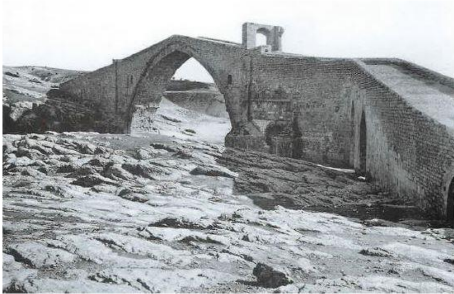
Şekil Ek 2.2. Malabadi Köprüsü memba cephesi (Gabriel, 2014)
