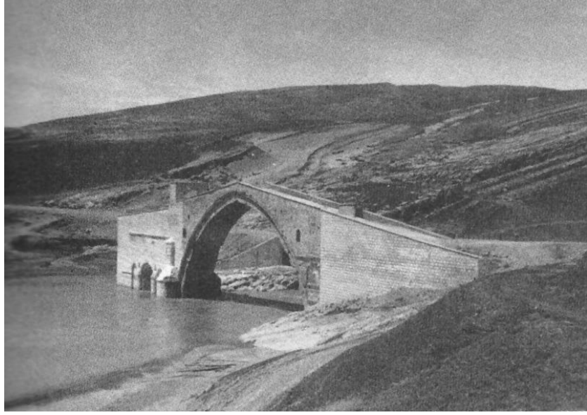
Şekil Ek 2.15. Malabadi Köprüsü mansap cephesi (Oğuz, 2001)
