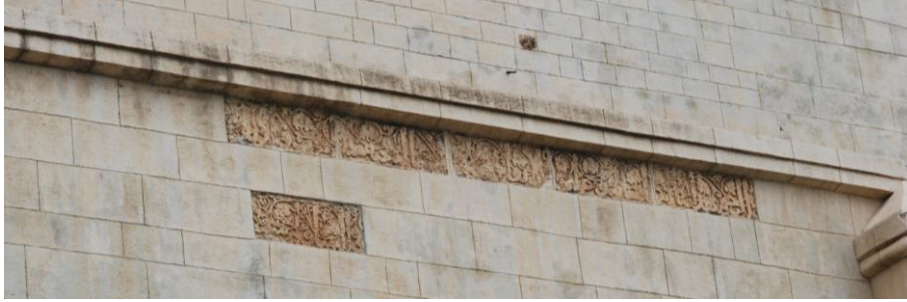
Şekil 2.1. Malabadi Köprüsündeki kitabe (KGM, 2009)
