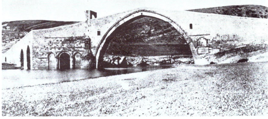
Şekil Ek 2.5. Malabadi Köprüsü memba cephesi (Çulpan, 2002)
