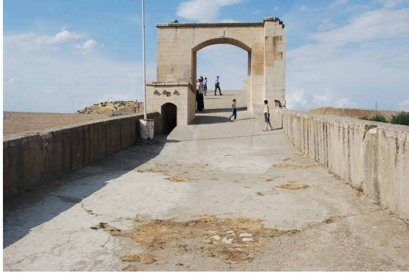
Şekil Ek 2.19. Restore öncesi döşeme üzerine atılan beton örtüsü (KGM, 2009)
