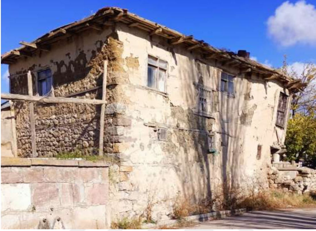
Şekil 3.6. Mehmet Ağa'nın eski evinin yol cephesi [38]
