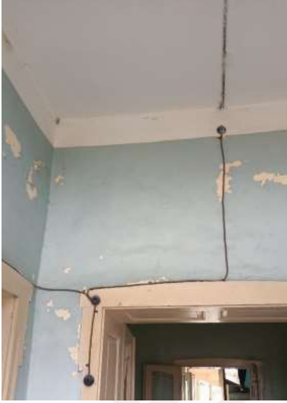
Şekil 4.6. Elektrik tesisat kablolarının yapı içerisinde dolaşımı
