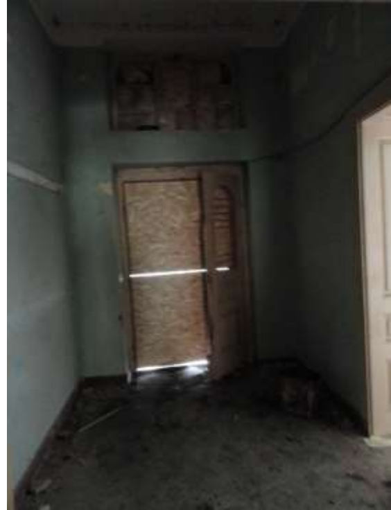
Şekil 5.10. Yonga levhalar ile kapatılan kapının içeriden görünümü (05.05.2021)
