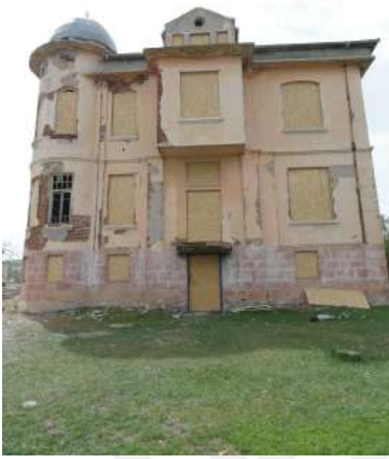
Şekil 5.7. Doğu cephesinde yonga levhalar ile kapatılan açıklıklar (05.05.2021)
